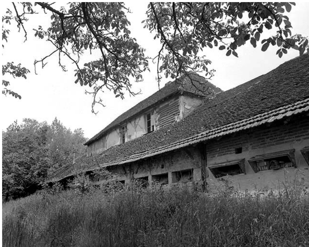
Pièce de séchage et logement d'ouvriers depuis le nord-ouest.
