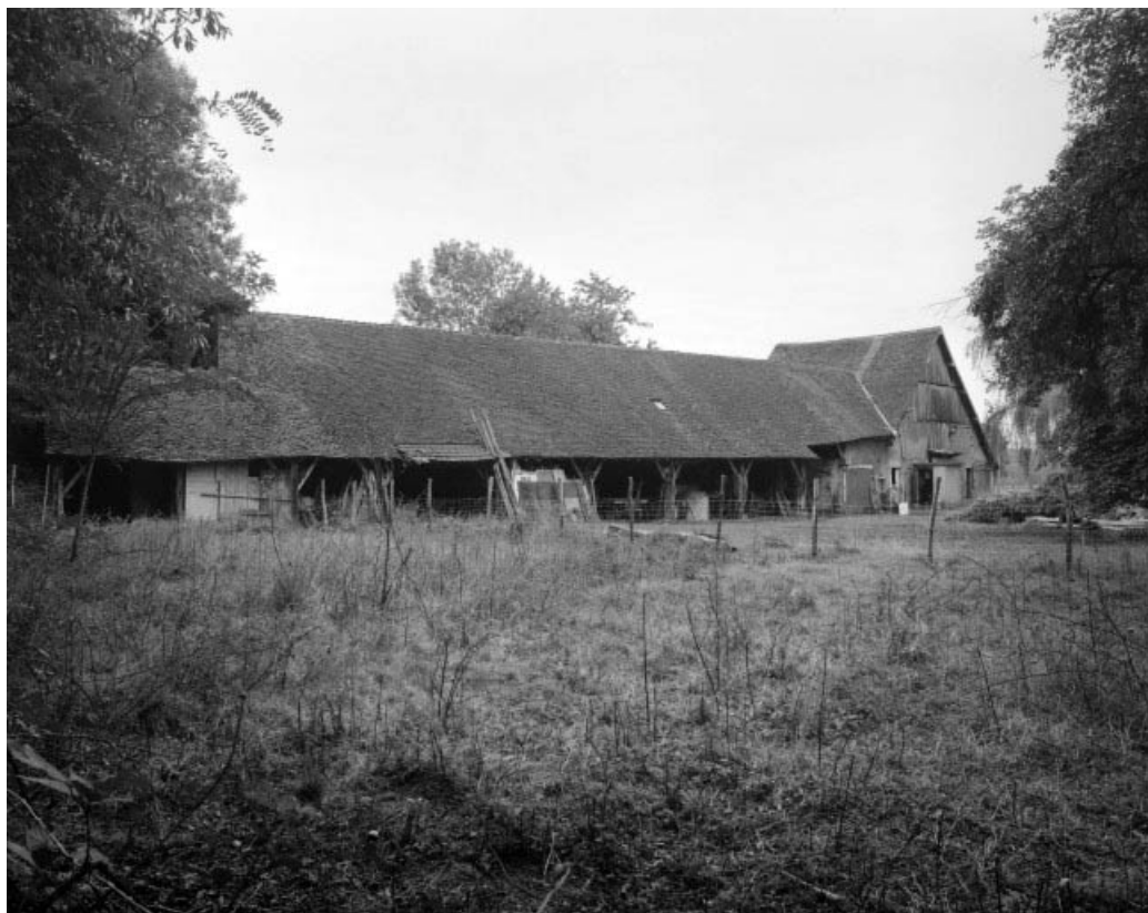
Pièce de séchage depuis le nord-ouest.
