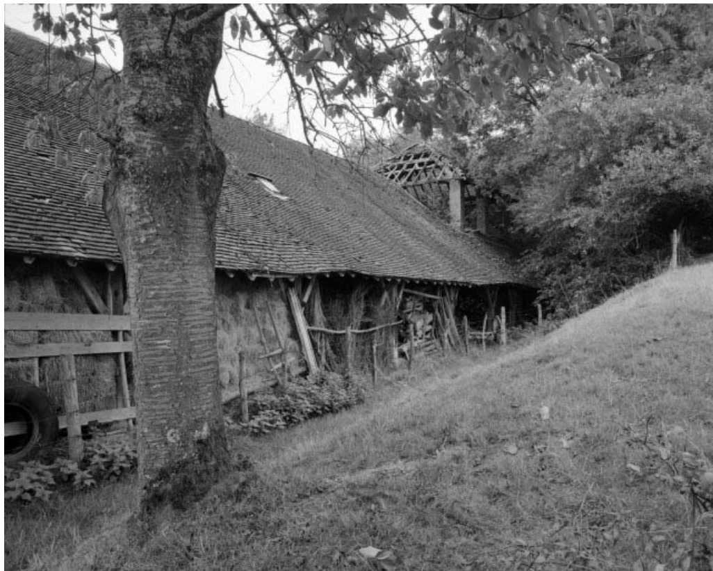
Pièce de séchage et four industriel depuis le sud-est.
