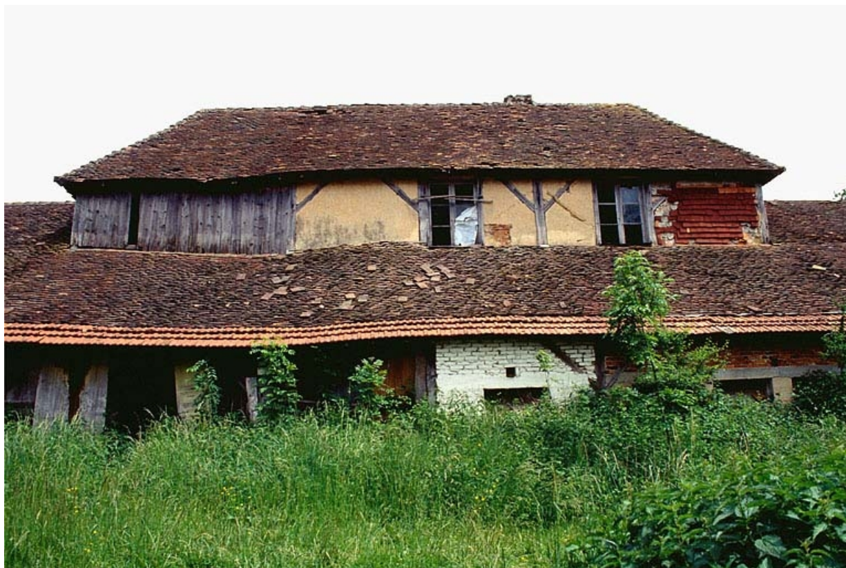
Façade ouest du logement d'ouvriers.
