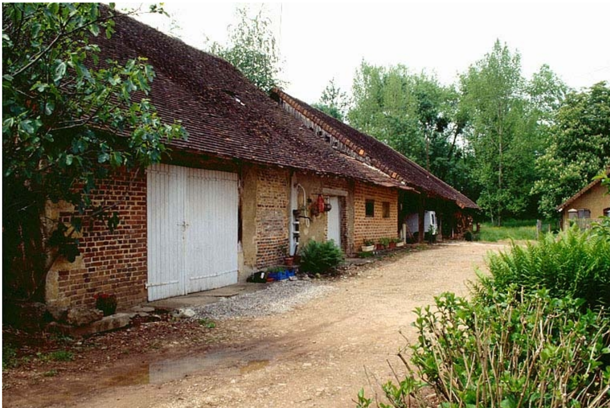
Remise et atelier de fabrication depuis le sud-est.
