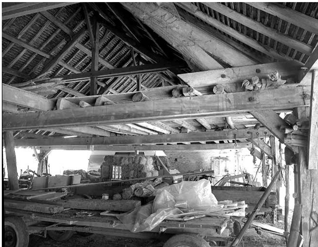
Vue intérieure de la pièce de séchage.
