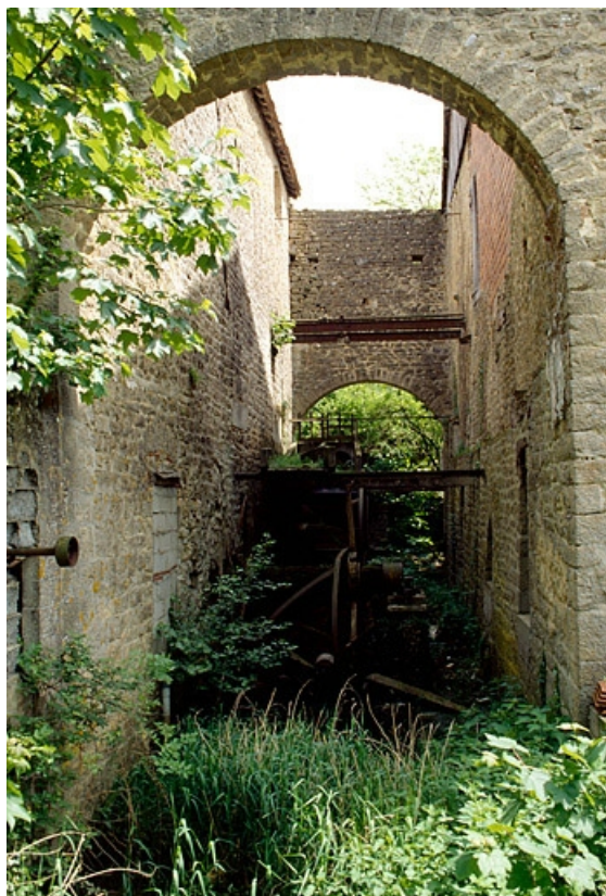
Bâtiment d'eau.Roues hydrauliques en ruine.
