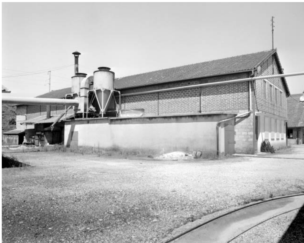
Atelier de fabrication, atelier de conditionnement, bureau.
