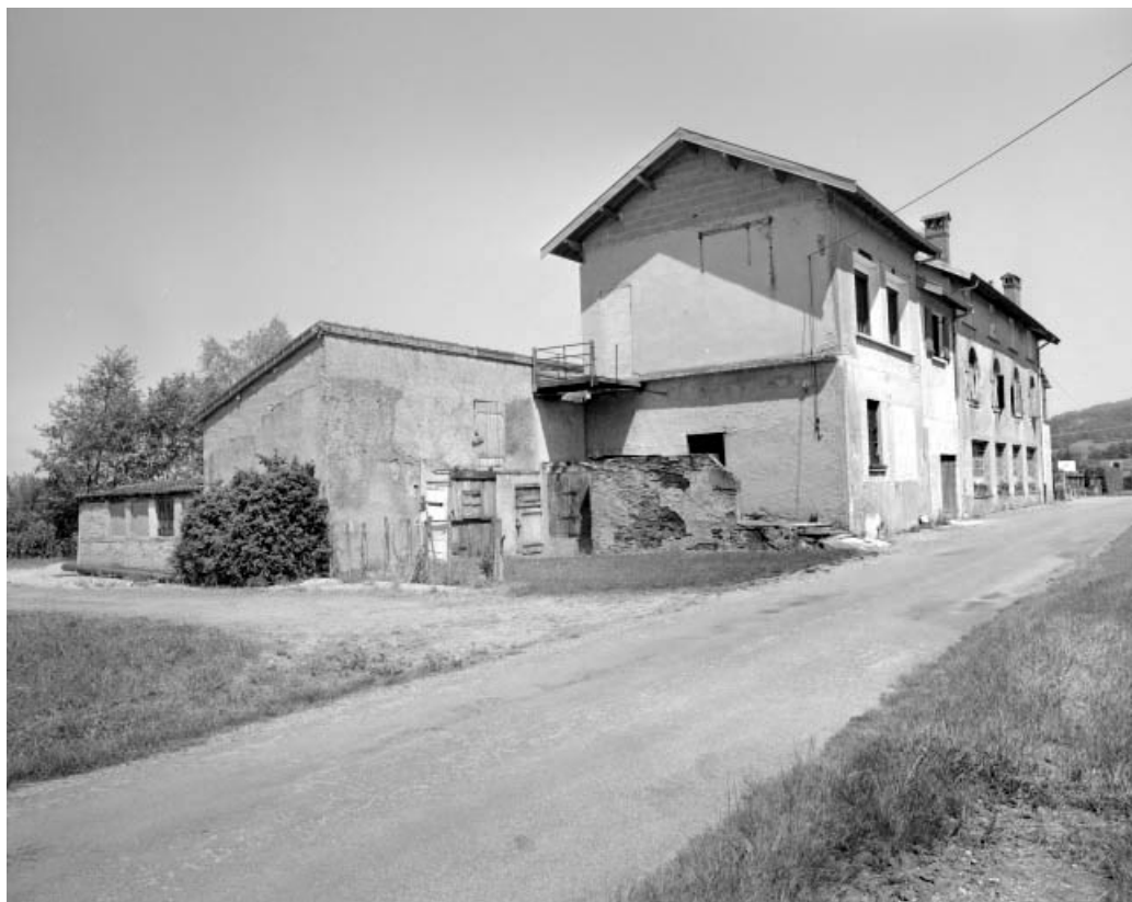
Logement et atelier de fabrication depuis l'ouest.
