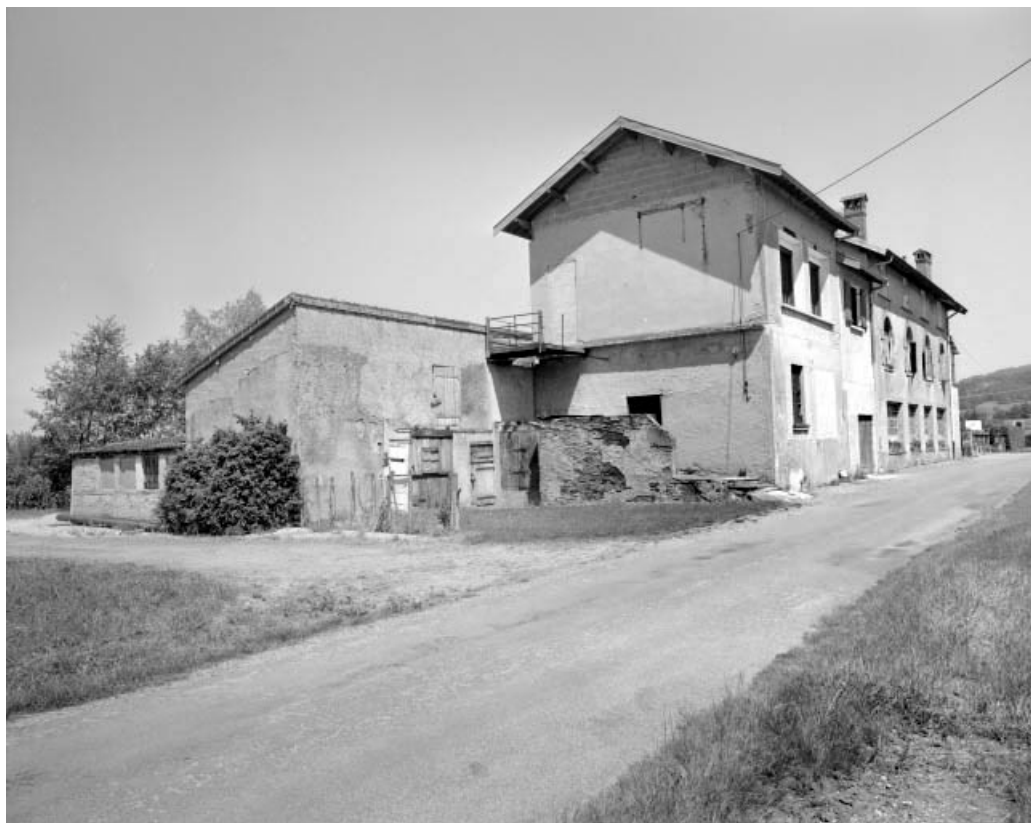
Logement et atelier de fabrication depuis l'ouest.
