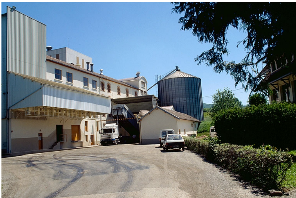
Atelier de fabrication et silos depuis l'entrée. 39, Vincelles quartier Minoterie
