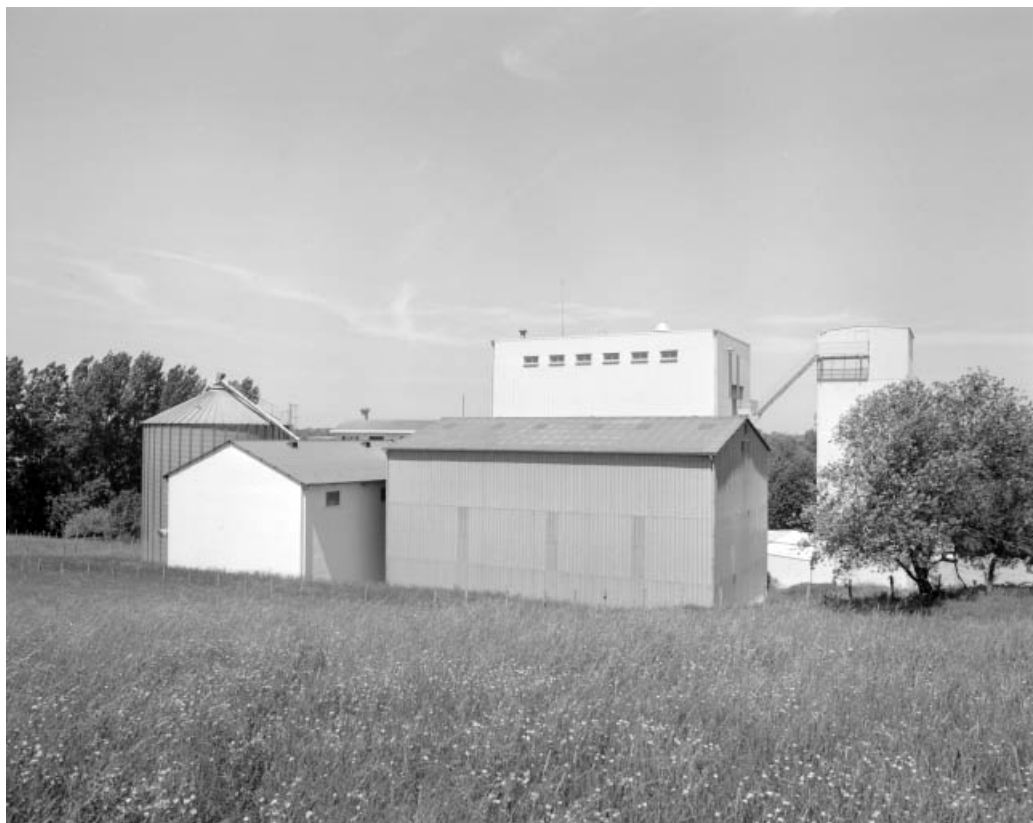
Silos et atelier de fabrication depuis le sud.
