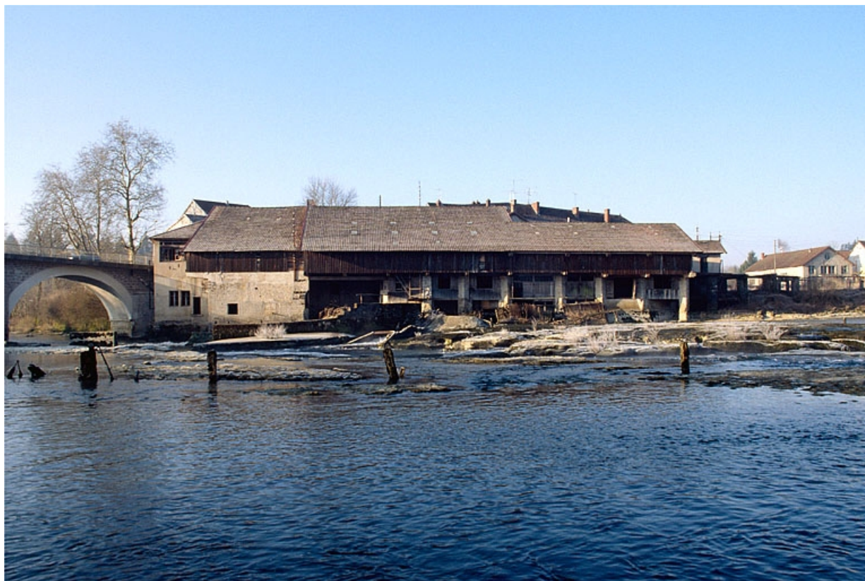
Façade de l'atelier de fabrication sur la rivière de l'Ain.
