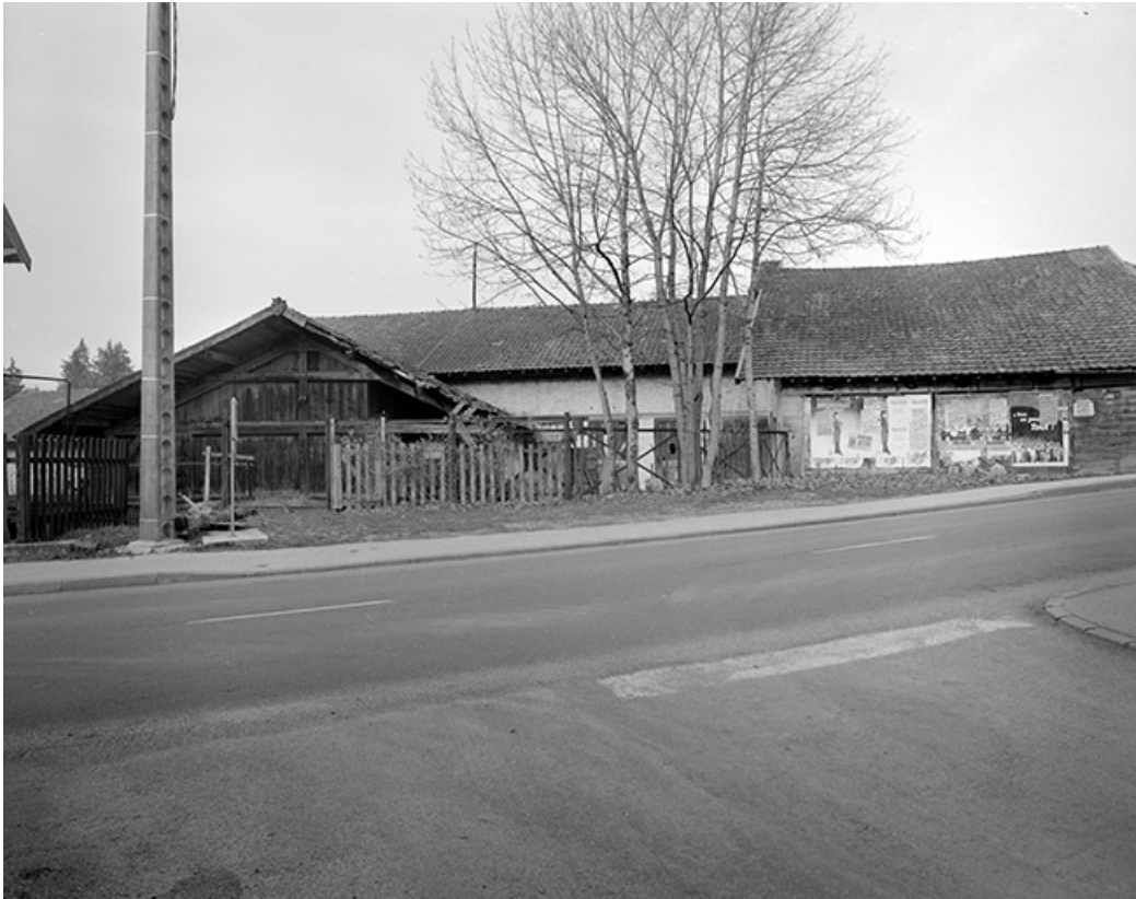
Atelier de fabrication depuis le sud. 39, Pont-de-Poitte Grande Rue 1, 3, 4, 6
