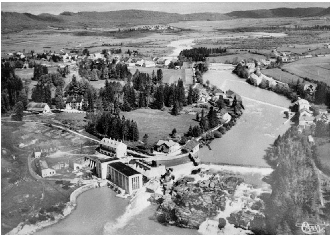
[Vue aérienne de la centrale hydroélectrique de la Saisse].
