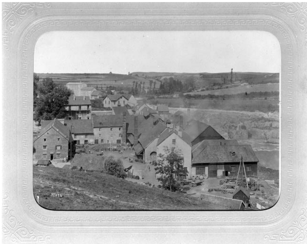
[Vue d'ensemble des forges de la Saisse depuis le sud], à la fin du 19e siècle.
