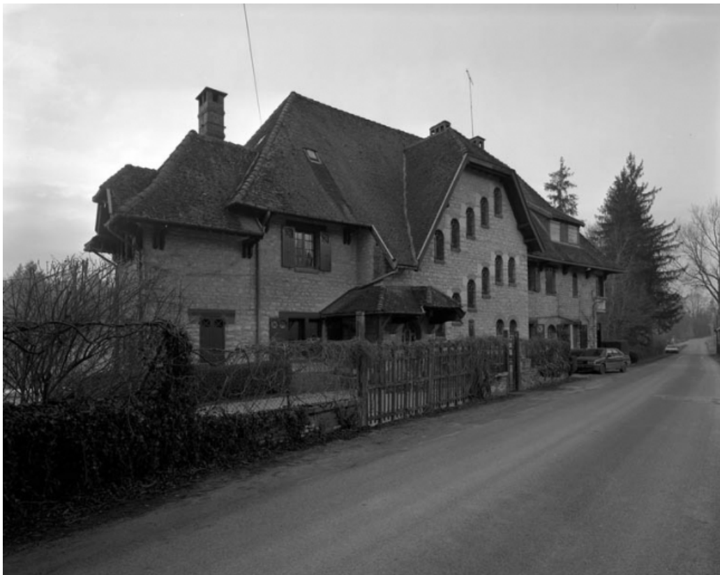
Façade antérieure du logement patronal de trois quarts gauche.
