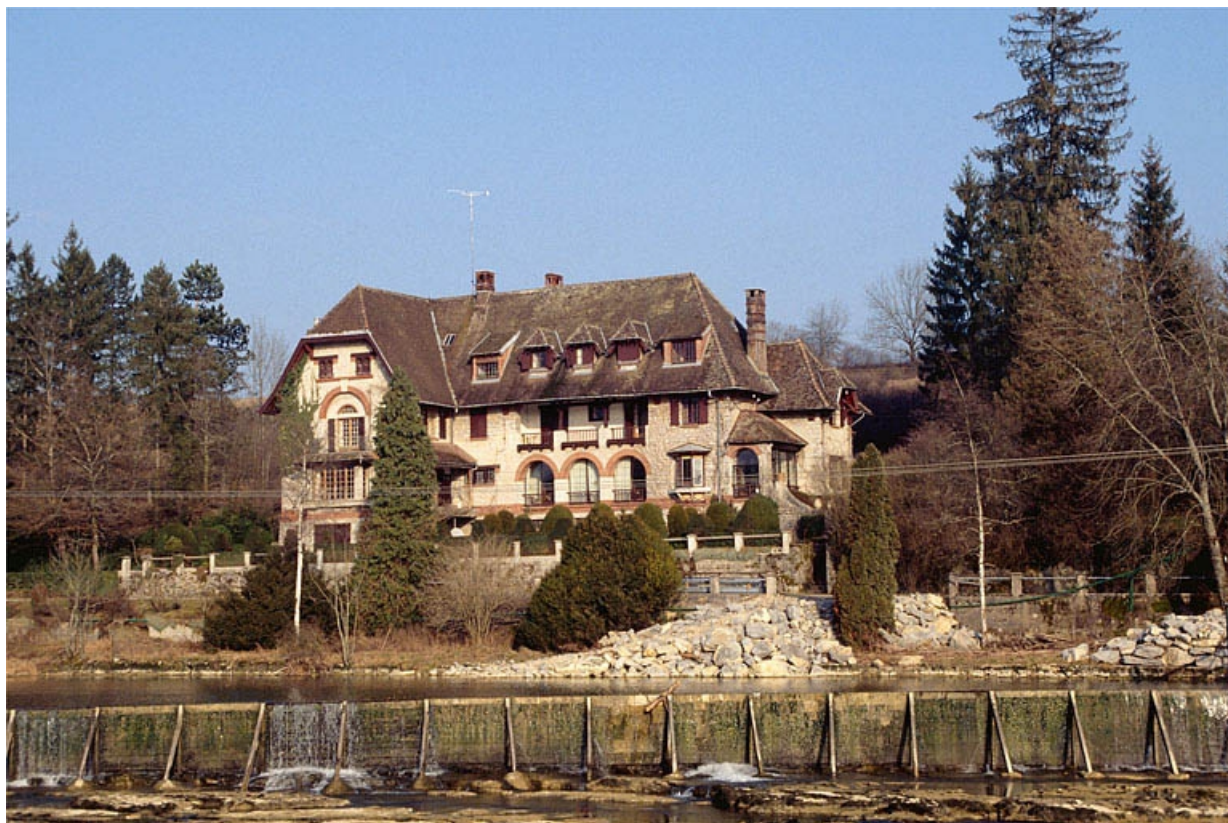
Façade antérieure du logement patronal.
