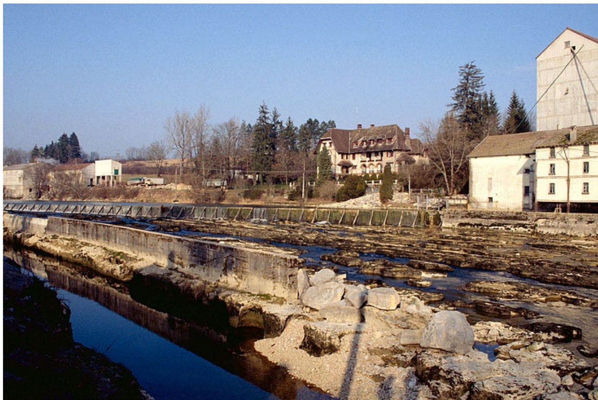
Vue d'ensemble depuis le sud.
