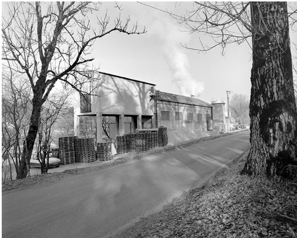
Entrepôt industriel et atelier de fabrication de l'usine de farine de bois.
