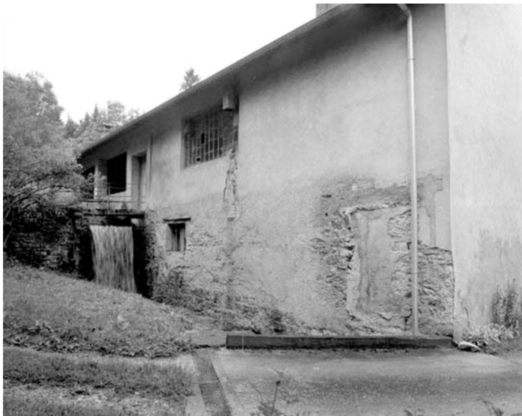
Façade postérieure de l'atelier de fabrication et canal.
