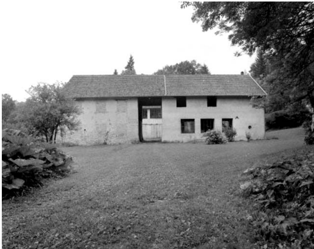
Façade postérieure de l'atelier de fabrication sud.
