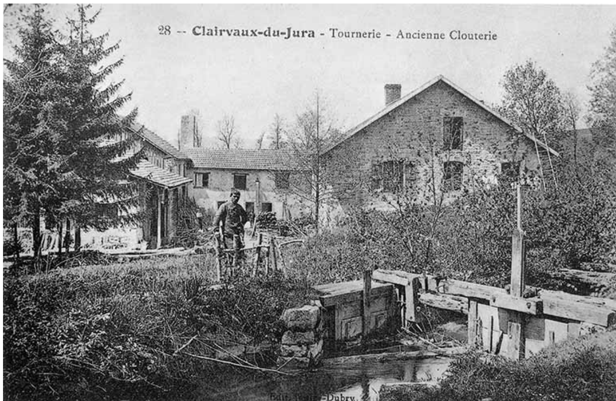
Clairvaux du Jura - Tournerie - Ancienne clouterie.
