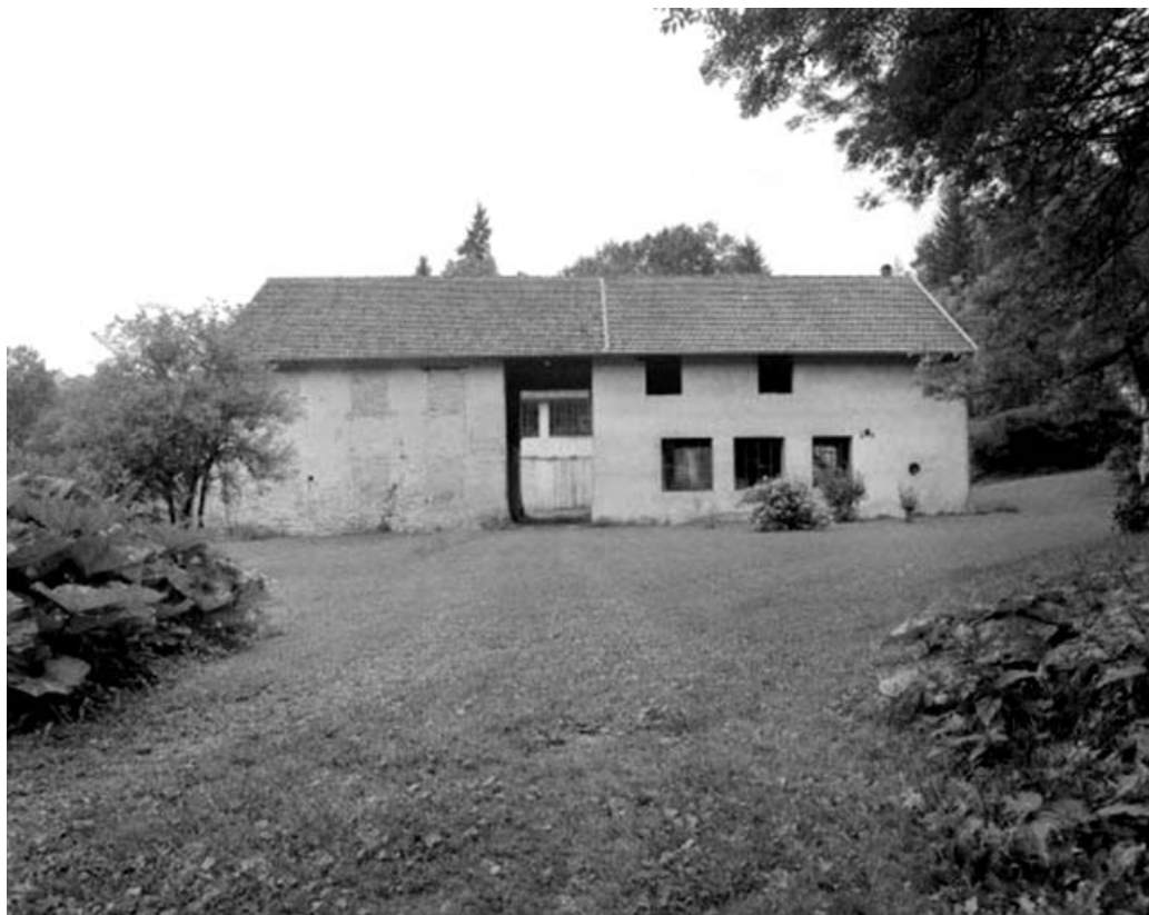
Façade postérieure de l'atelier de fabrication sud.
