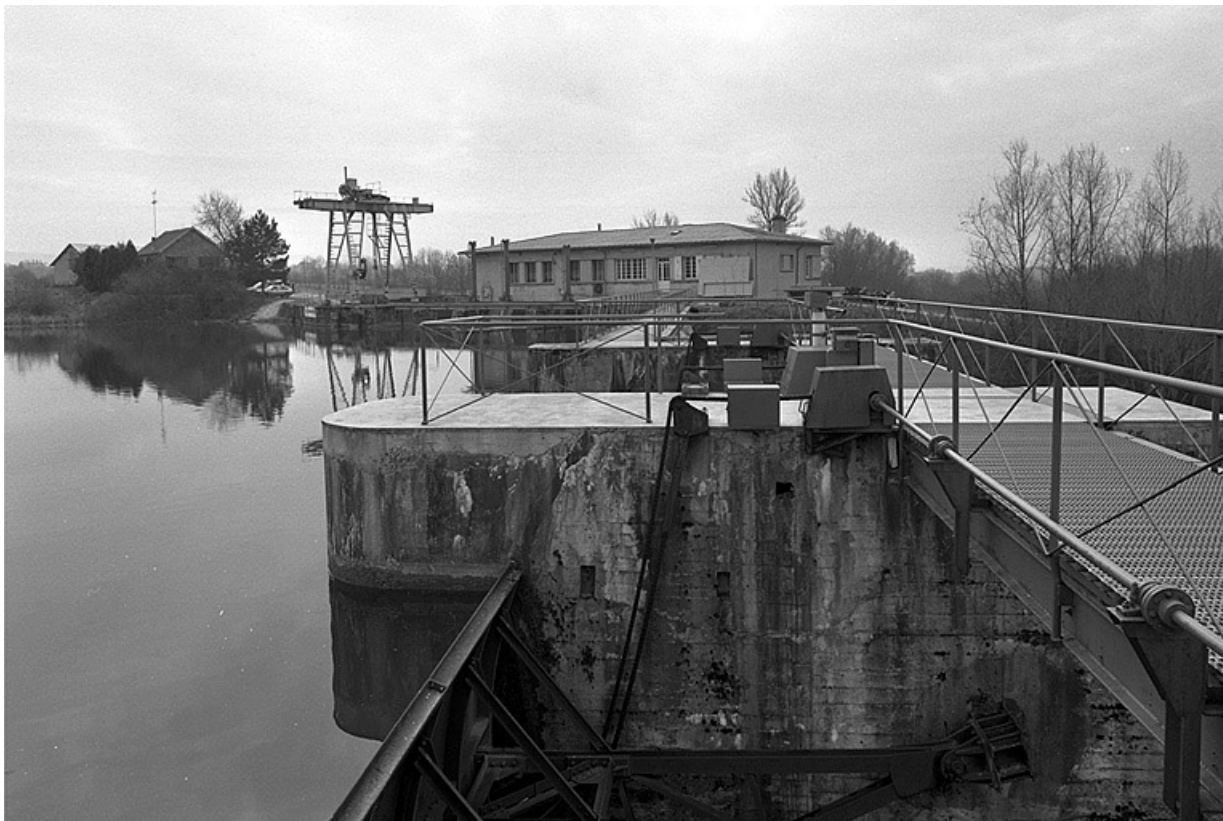
De gauche à droite :logement, pont roulant, salle des machines, barrage et vannes-secteur au premier plan. 39, Charézier, lieudit : Liefnans
