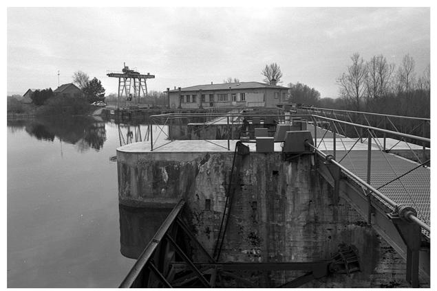
De gauche à droite :logement, pont roulant, salle des machines, barrage et vannes-secteur au premier plan.
