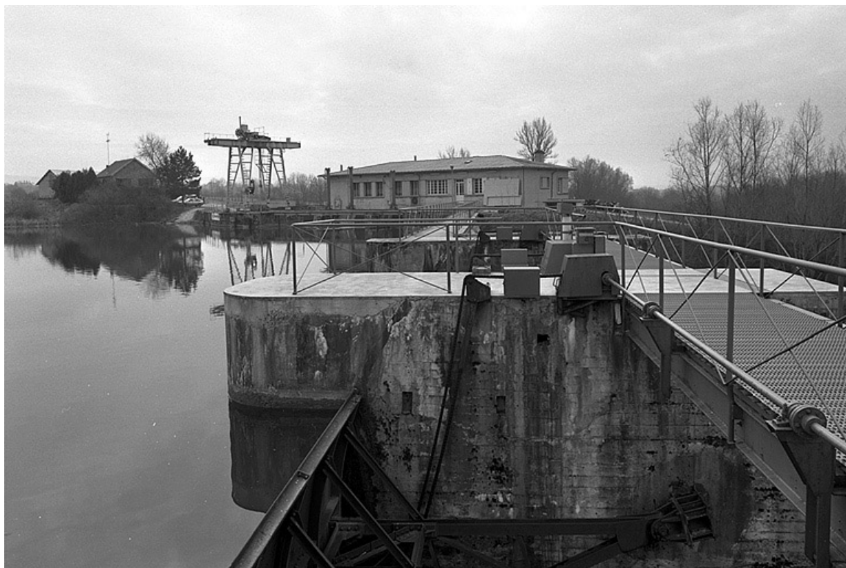
De gauche à droite :logement, pont roulant, salle des machines, barrage et vannes-secteur au premier plan. 39, Charézier, lieudit : Liefnans
