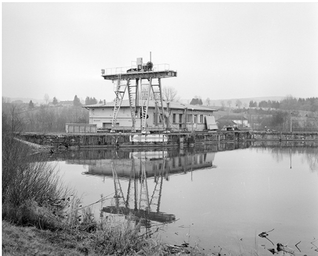
Pont roulant et salle des machines depuis le nord-est.
