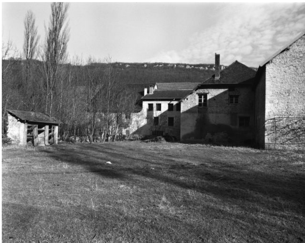
Façade ouest. De gauche à droite : ferme, logement, atelier de fabrication et bergerie. 39, Nevy-sur-Seille rue du Moulin
