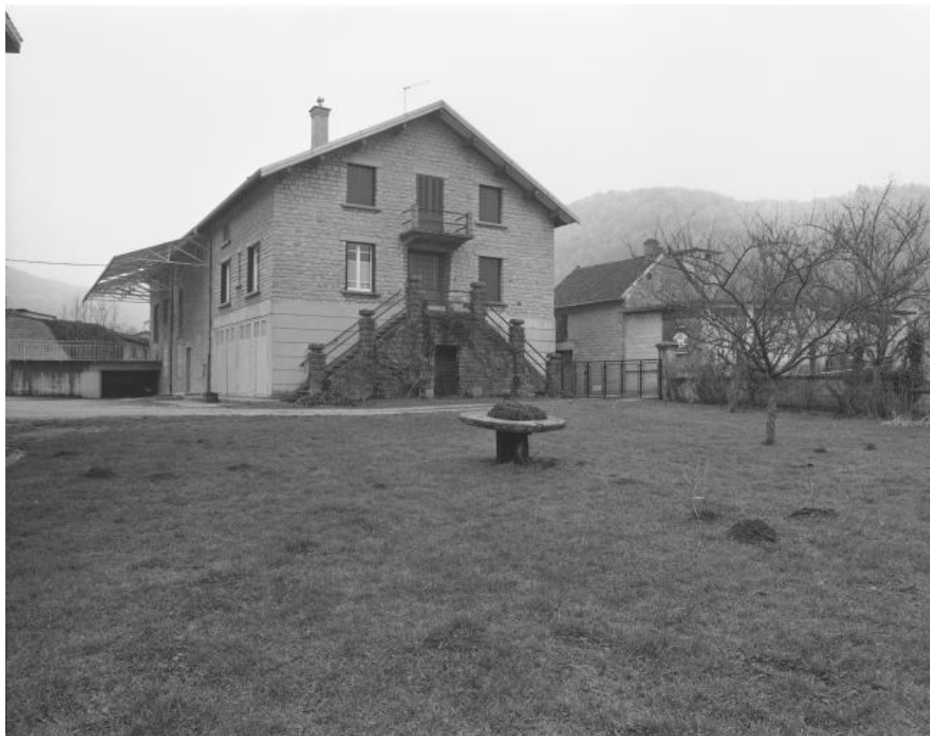
Pignon nord. A droite : four et entrepôt industriel.
