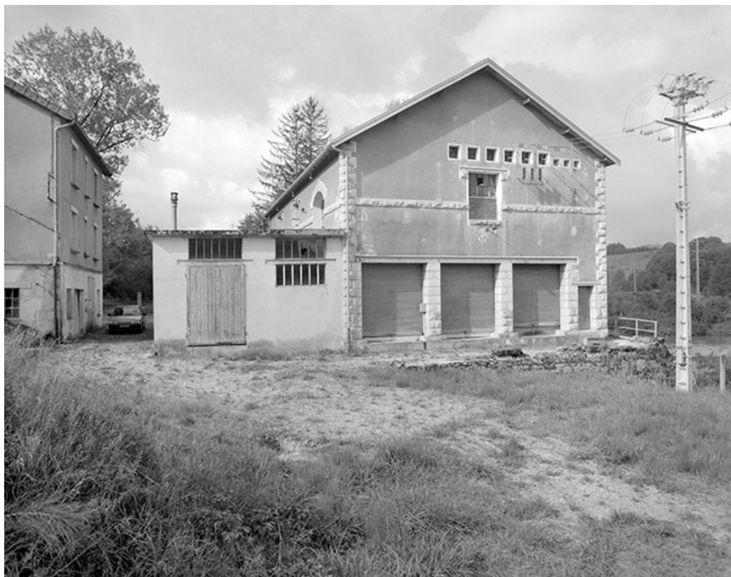
Façade latérale droite de la centrale.
