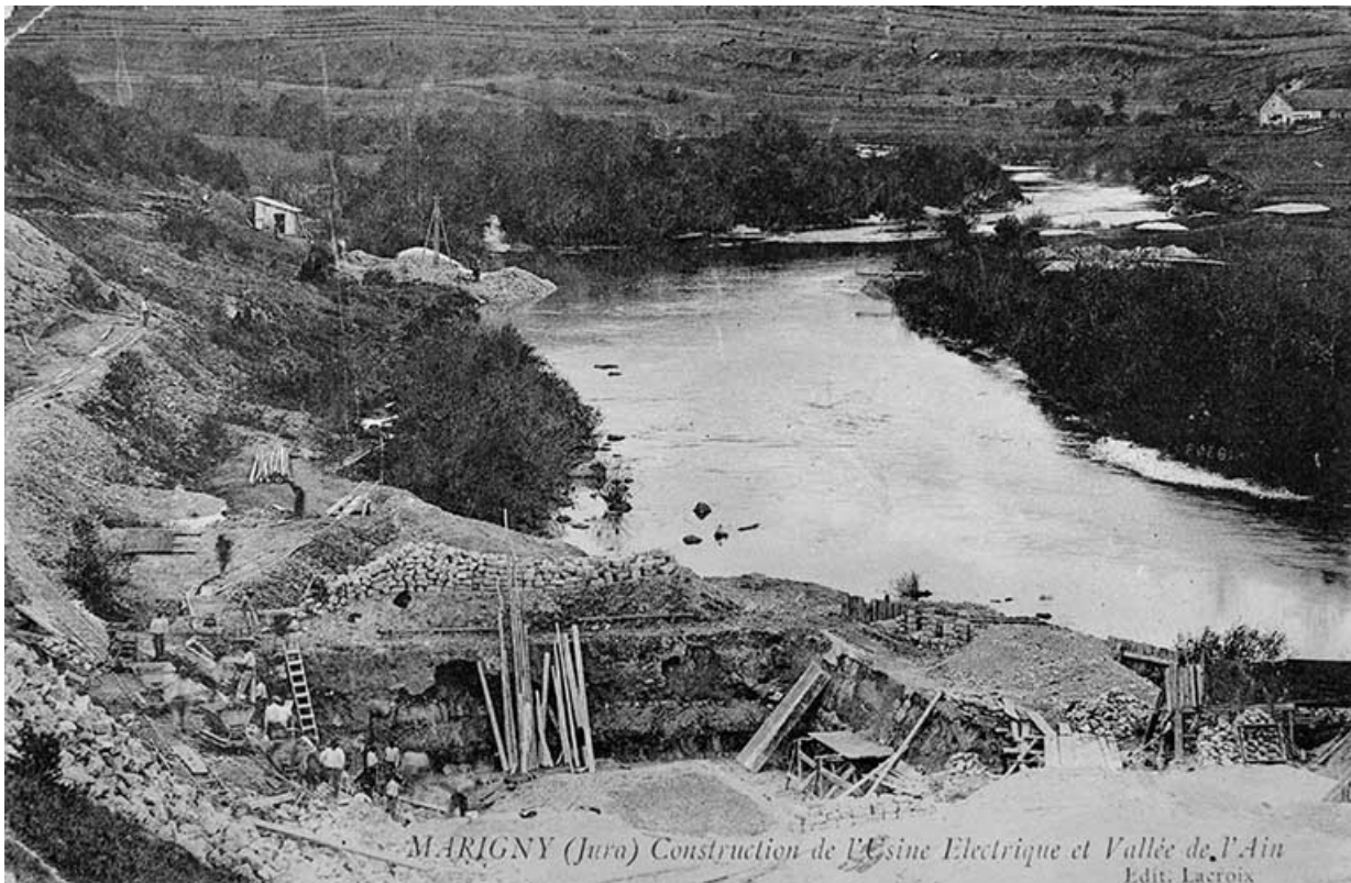
Marigny (Jura) Construction de l'Usine Electrique et Vallée de l'Ain.
