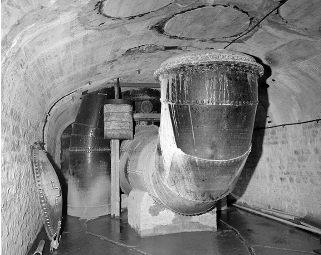
Intérieur de la centrale : collecteur en soubassement. Au premier plan, coude desservant autrefois le groupe de 1912. 39, Marigny V.C. 204
