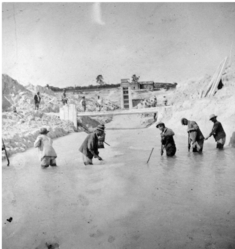
Prise d'eau vue d'amont [délayage de la marne]. 39, Marigny V.C. 204
