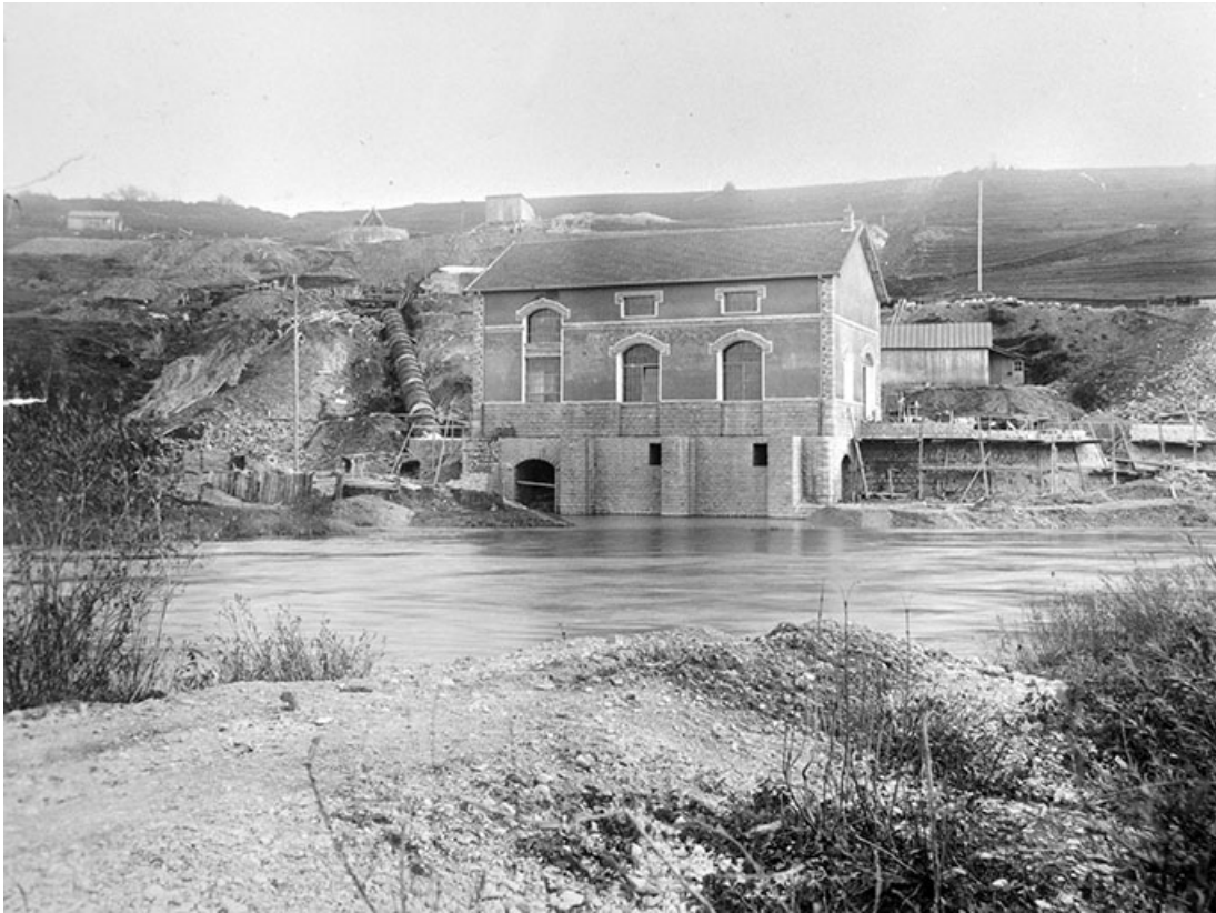
Centrale et conduite forcée en cours d'achèvement. 03, Marigny V.C. 204
