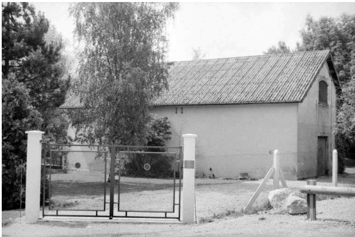
Bâtiment de prise d'eau.
