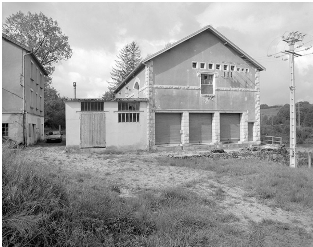
Façade latérale droite de la centrale.
