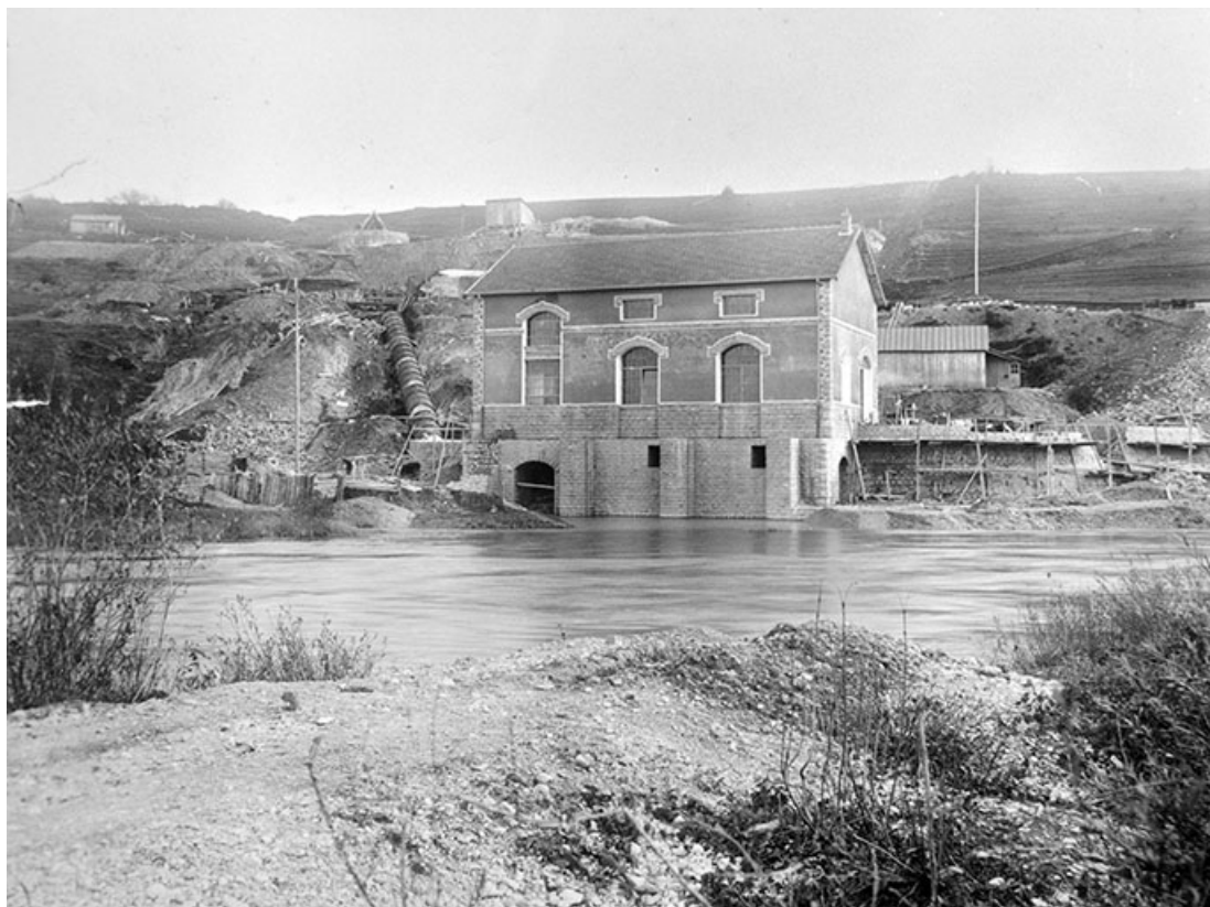
Centrale et conduite forcée en cours d'achèvement.
