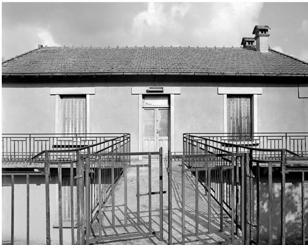
Façade antérieure du logement d'ouvriers.
