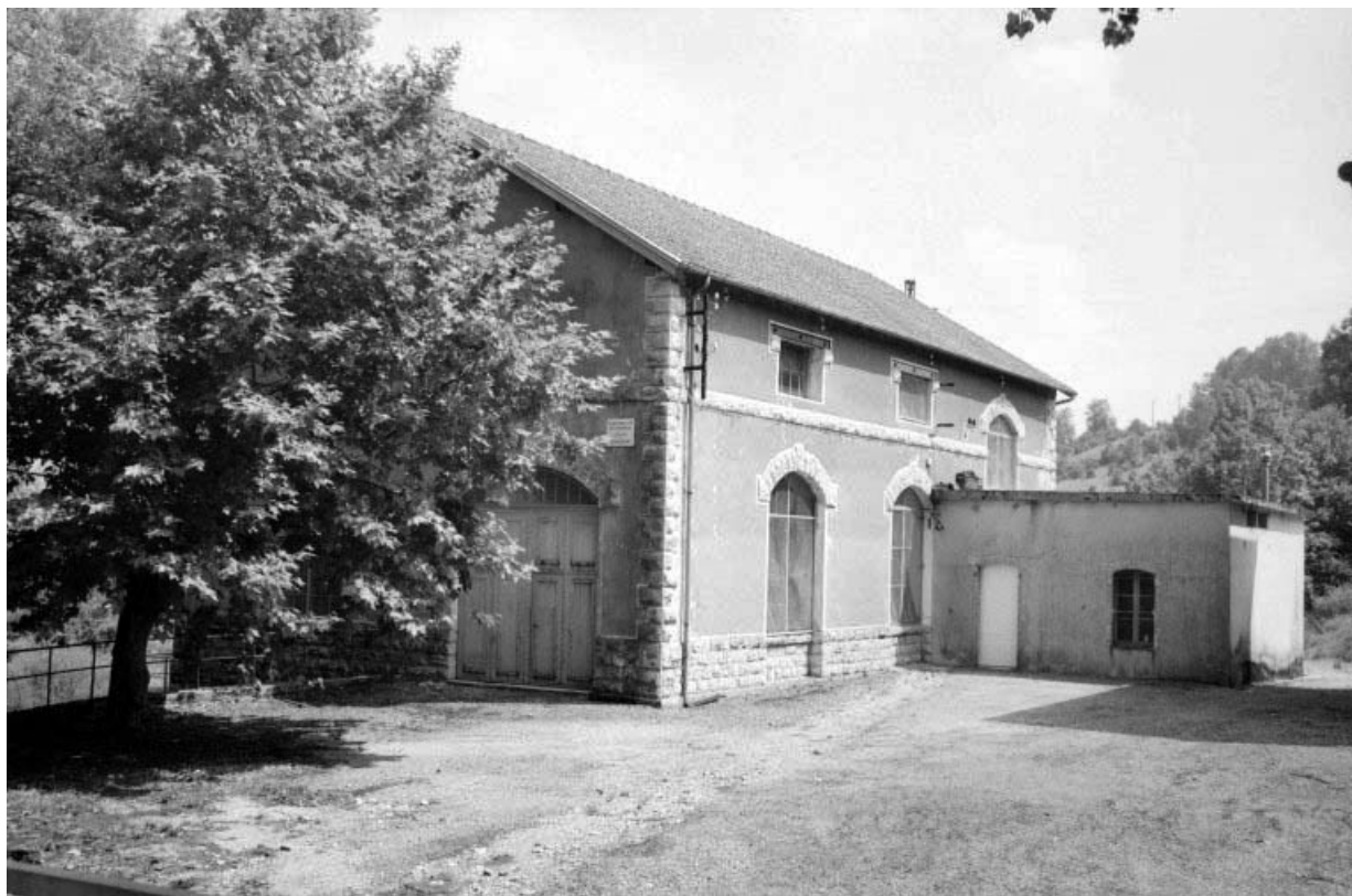
Façades antérieure et latérale gauche de la centrale.
