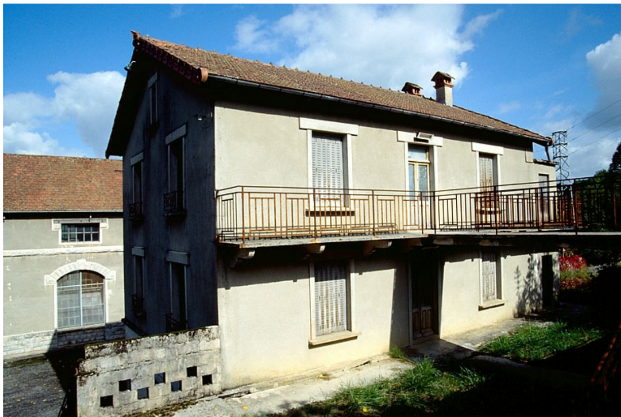
Façade antérieure du logement d'ouvriers, de trois quarts gauche. 39, Marigny V.C. 204
