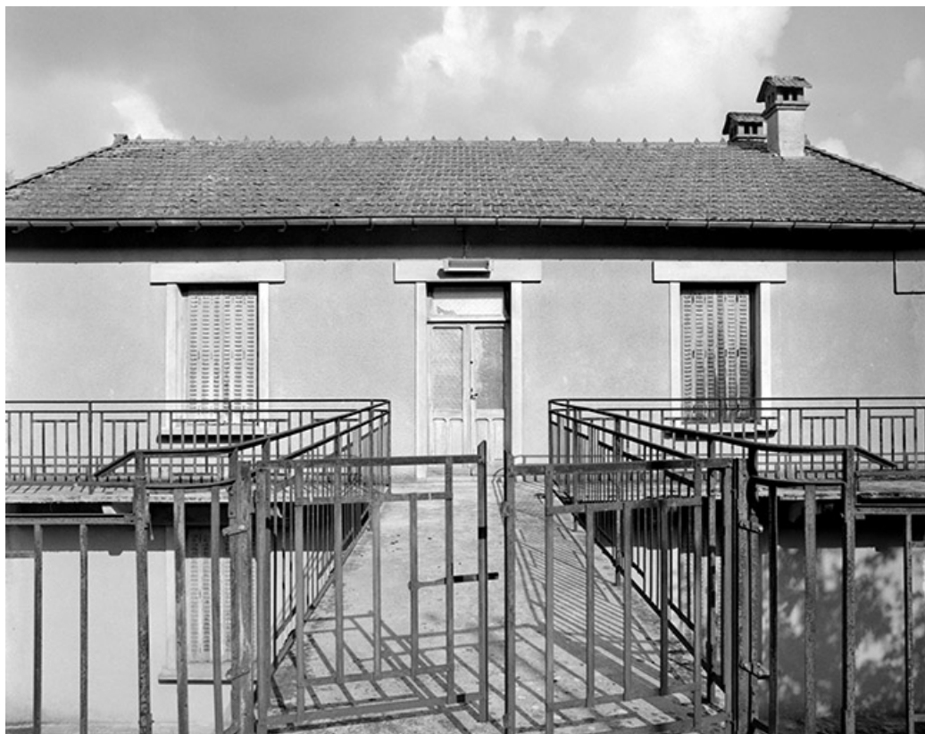
Façade antérieure du logement d'ouvriers.
