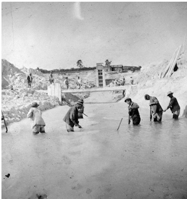
Prise d'eau vue d'amont [délayage de la marne]. 03, Marigny V.C. 204
