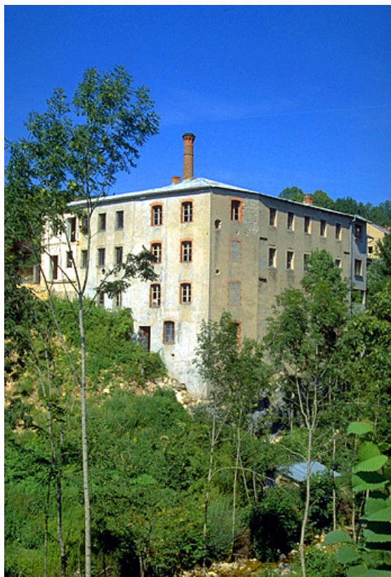
Partie ancienne (atelier de fabrication et bureau). 39, Villards-d'Héria
