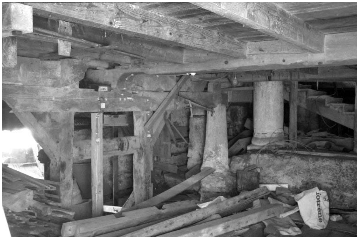
Transmission, support des meules et colonnes (2e étage de soubassement). 39, Villards-d'Héria
