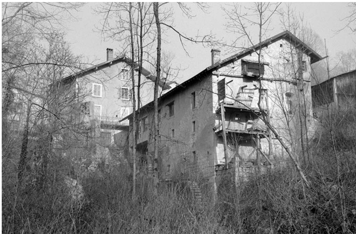
Façades postérieure et latérale gauche des ateliers de fabrication.
