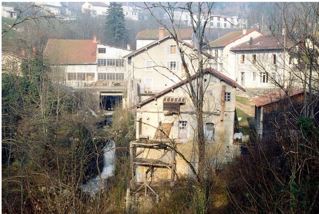
Vue d'ensemble depuis l'aval. 39, Villards-d'Héria
