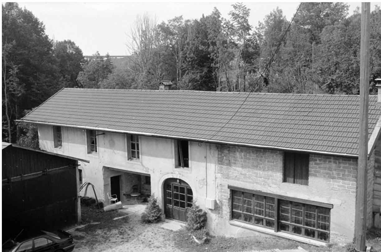
Façade antérieure des ateliers de fabrication.
