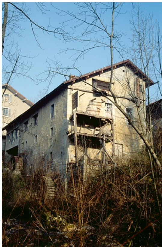
Façades postérieure et latérale gauche des ateliers de fabrication (cadrage vertical). 39, Villards-d'Héria
