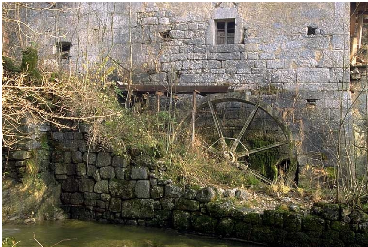
Roue hydraulique verticale aval.
