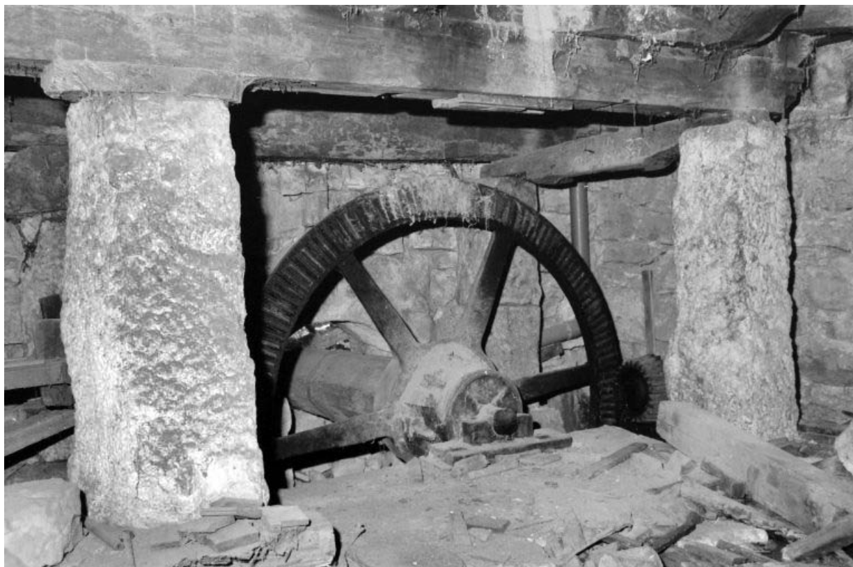
Transmission d'une roue hydraulique (2e étage de soubassement). 39, Villards-d'Héria
