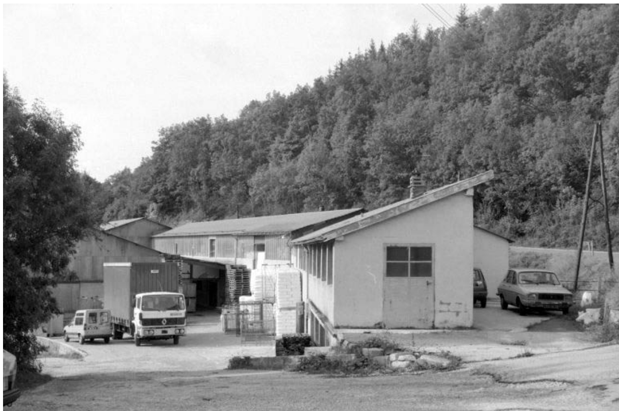
Atelier de fabrication et magasins industriels (usine des années 1950). 39, Villards-d'Héria
