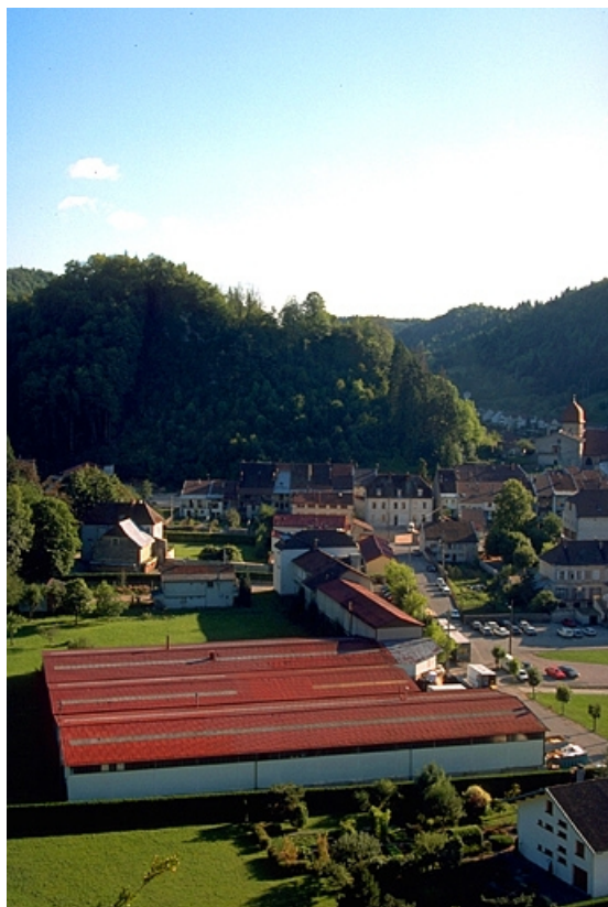
Vue d'ensemble plongeante depuis le nord. 39, Moirans-en-Montagne, 4, 6 rue des Sports
