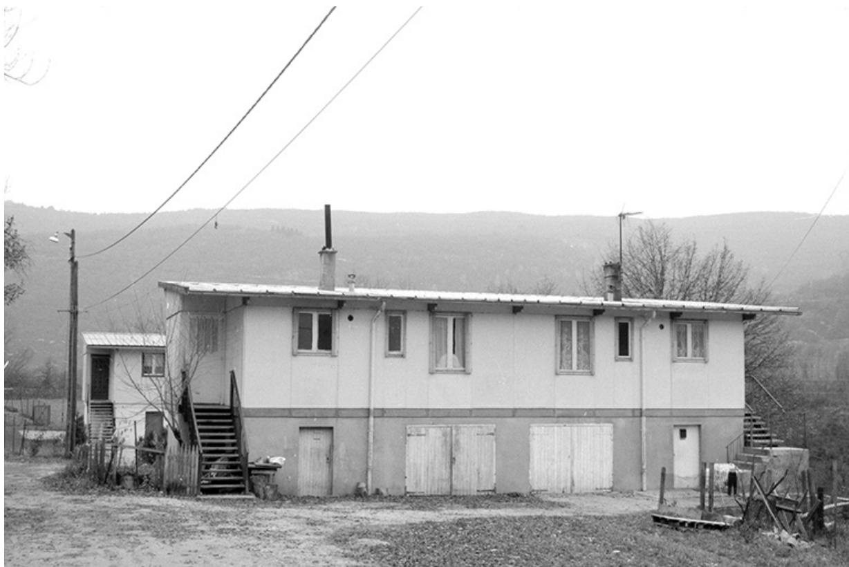
Façade antérieure d'une autre maison de la série. Maison cadastrée 1985 AN 122.
