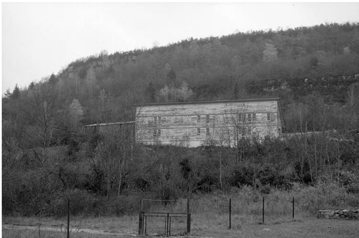
Vue d'ensemble depuis l'ouest (façade postérieure).
