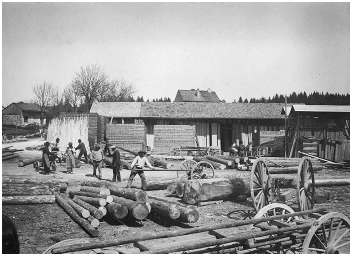
St Laurent. La scierie (chantier devant l'usine).
