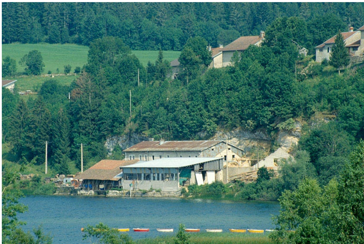
Atelier de fabrication et magasin industriel, vus de l'ouest.
