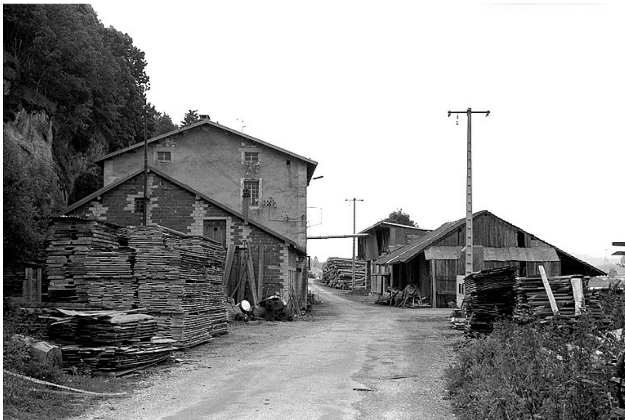
Atelier de réparation, ancien atelier de fabrication et magasin industriel.
