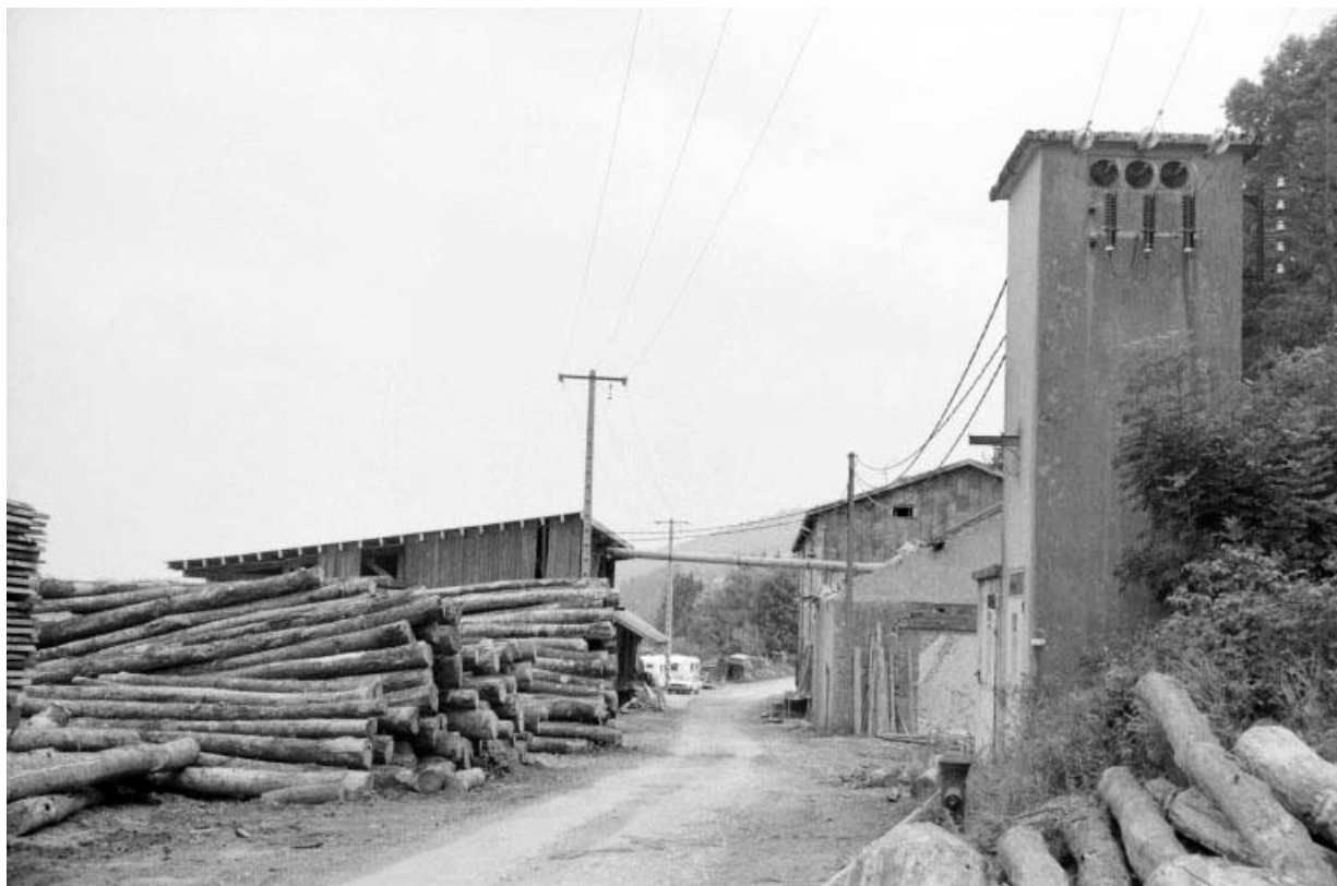
Aire des matières premières, atelier de fabrication et transformateur.
