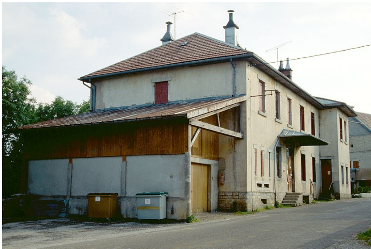
Façades antérieure et latérale gauche.
