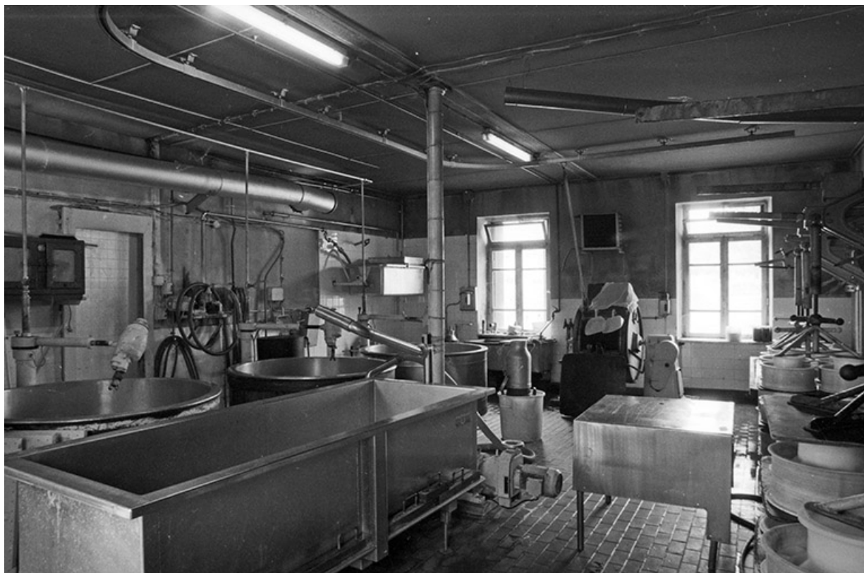
Intérieur de l'atelier de fabrication.
