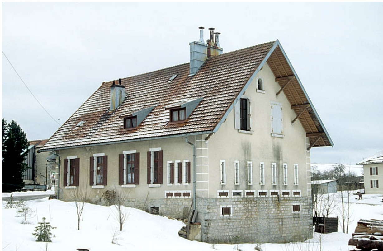
Façades postérieure et latérale droite.
