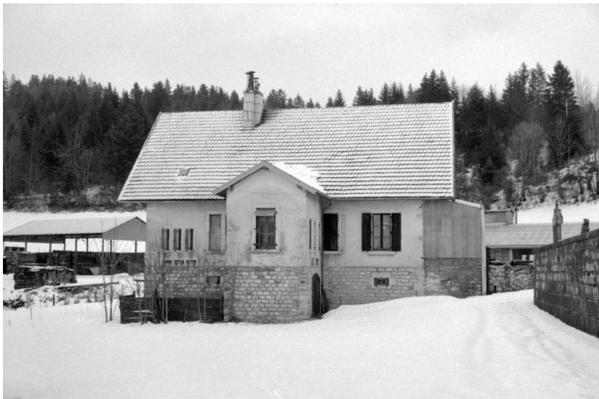
Façade latérale gauche.
