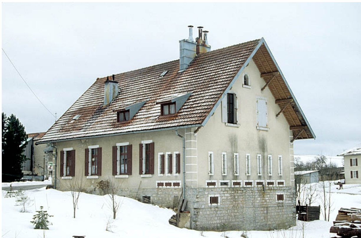
Façades postérieure et latérale droite.
