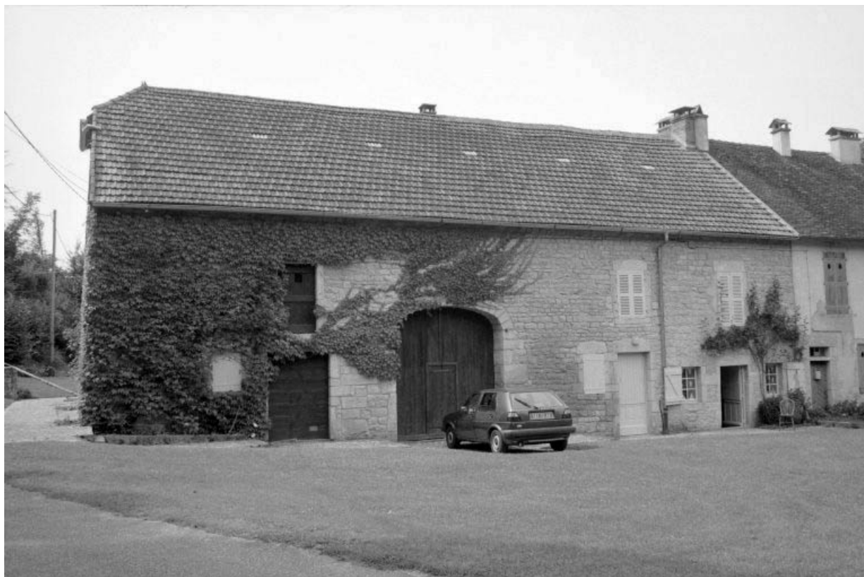
Façade postérieure de l'étable.
