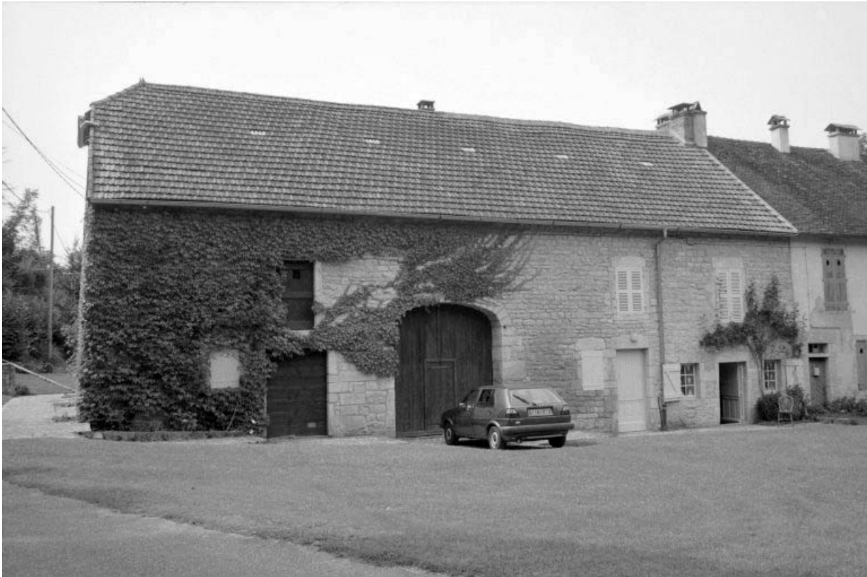
Façade postérieure de l'étable.
