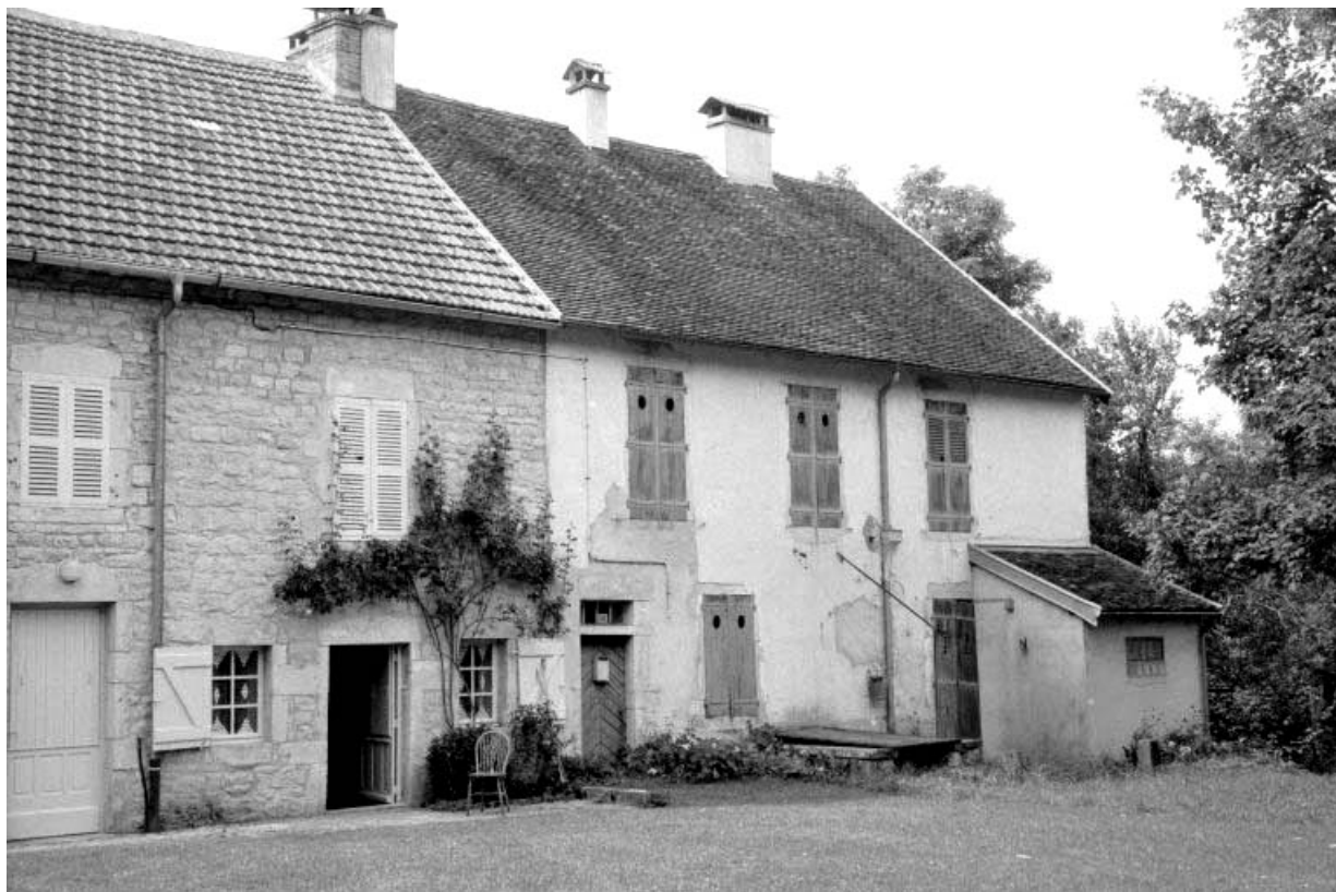
Façade postérieure du logement.
