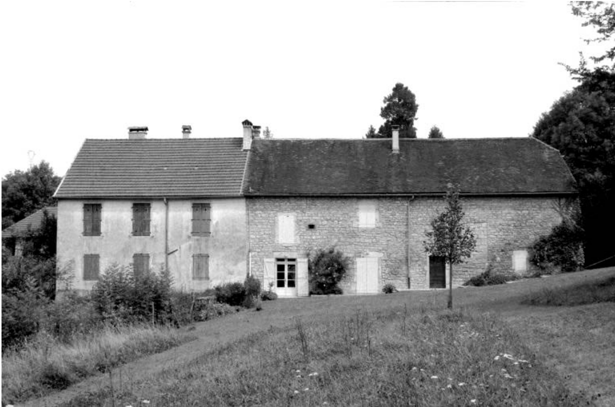
Façade antérieure du logement et de l'étable.
