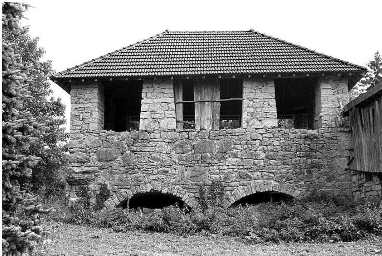
Four : ouvertures du foyer.
