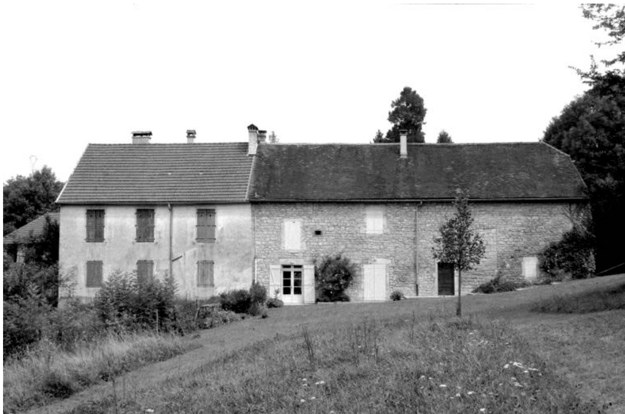
Façade antérieure du logement et de l'étable.
