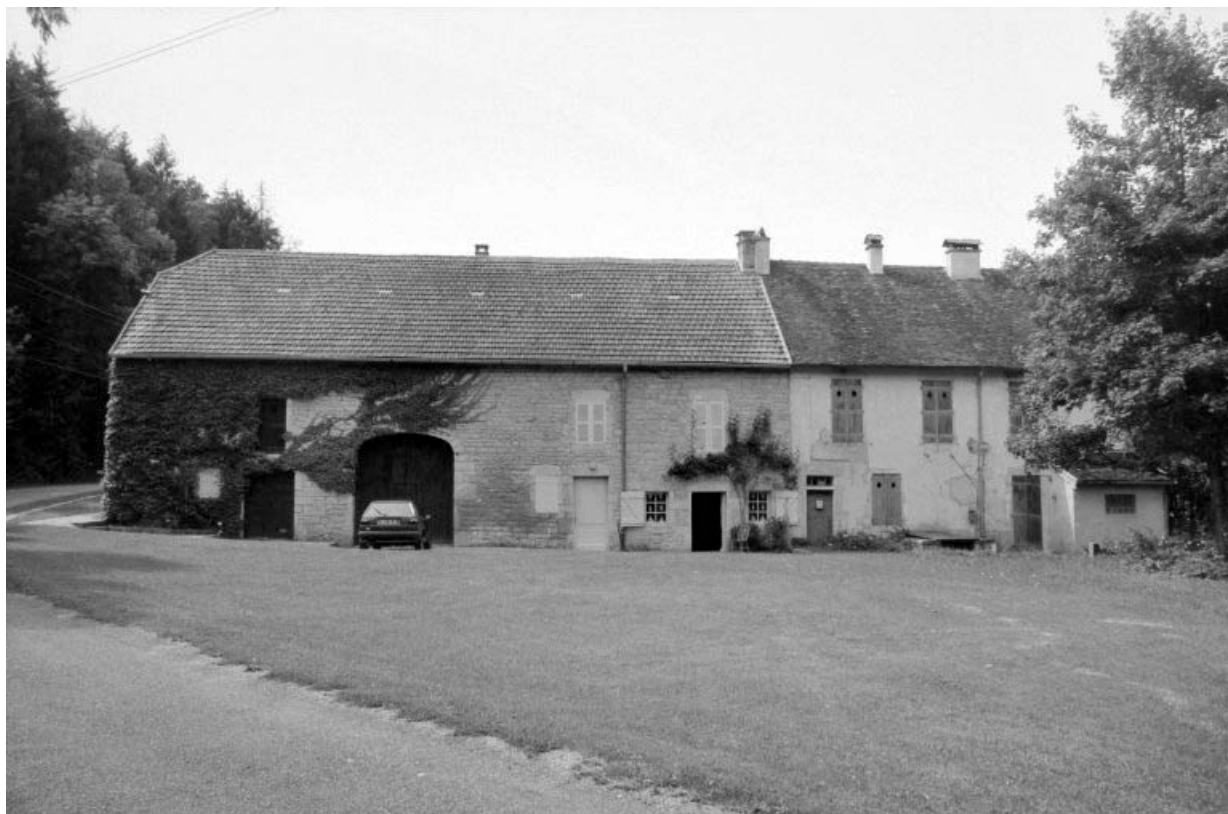
Façade postérieure du logement et de l'étable.
