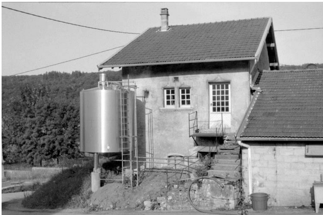
Façade postérieure de la maison.
