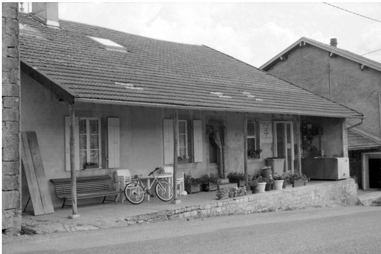
Façade antérieure de la fromagerie.
