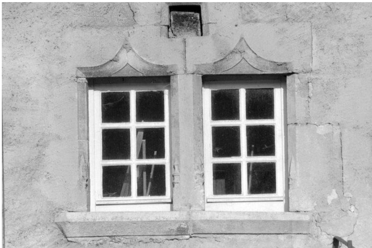
Maison : détail des fenêtres couvertes d'un arc en accolade. 39, Rathonay
