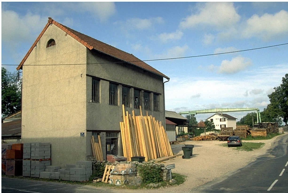
Magasin industriel, atelier de fabrication et poste de chargement.
