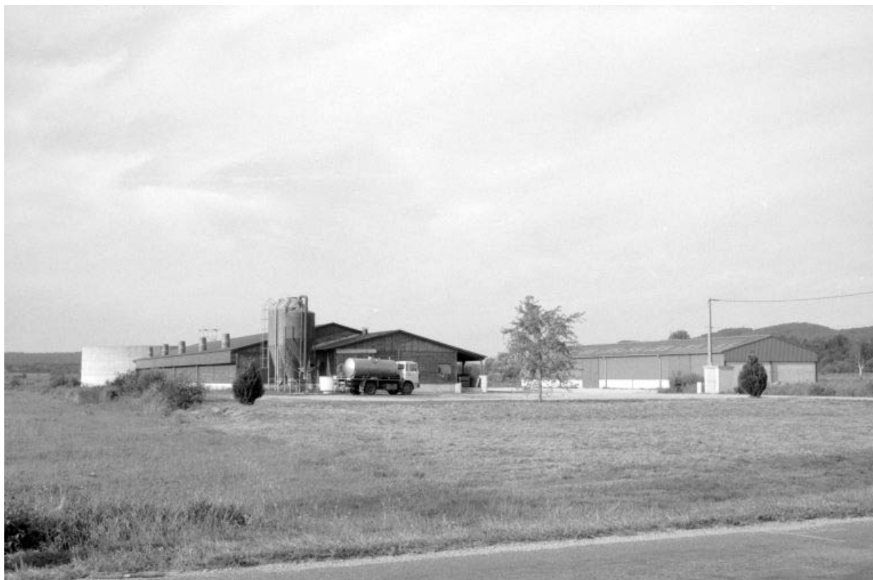
Porcherie et cave d'affinage vues du sud-ouest.
