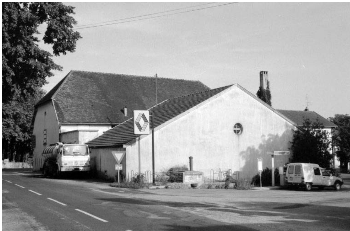
Fromagerie et pièce d'affinage vues du nord-ouest.
