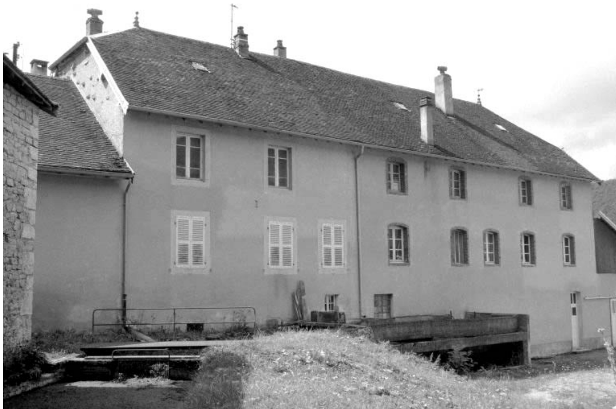
Façade postérieure du premier atelier de fabrication.
