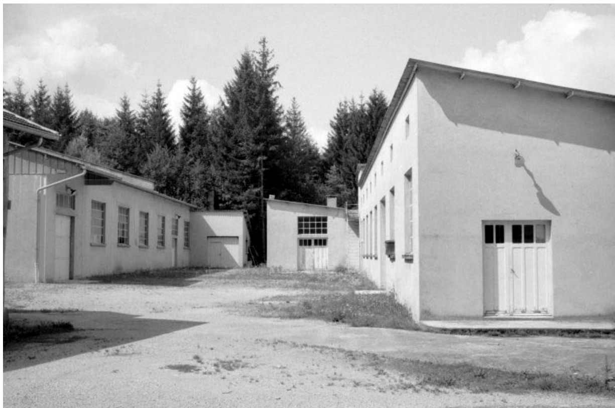
Ateliers récents. Atelier de fabrication à gauche, chaufferie et atelier de conditionnement à droite.
