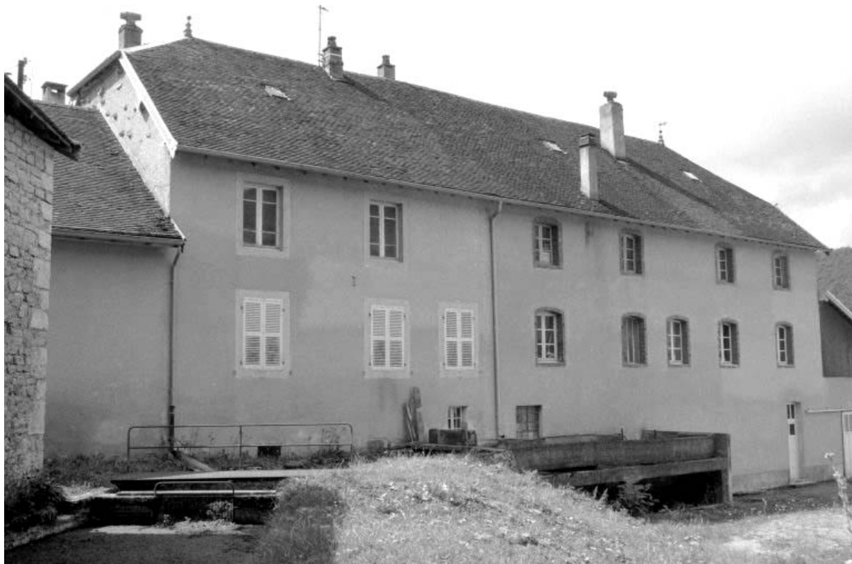
Façade postérieure du premier atelier de fabrication.
