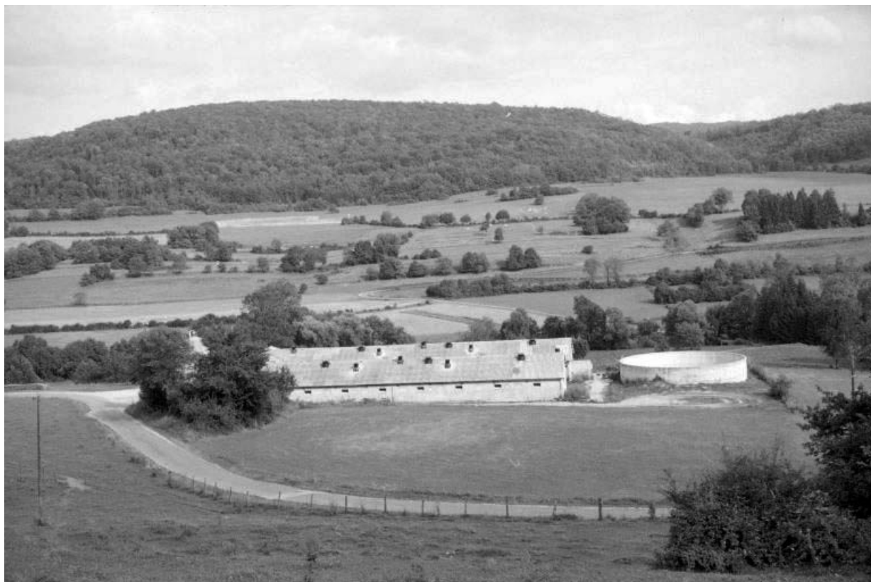
Porcherie vue du nord-ouest. 39, Chambéria, lieudit : Sancia
