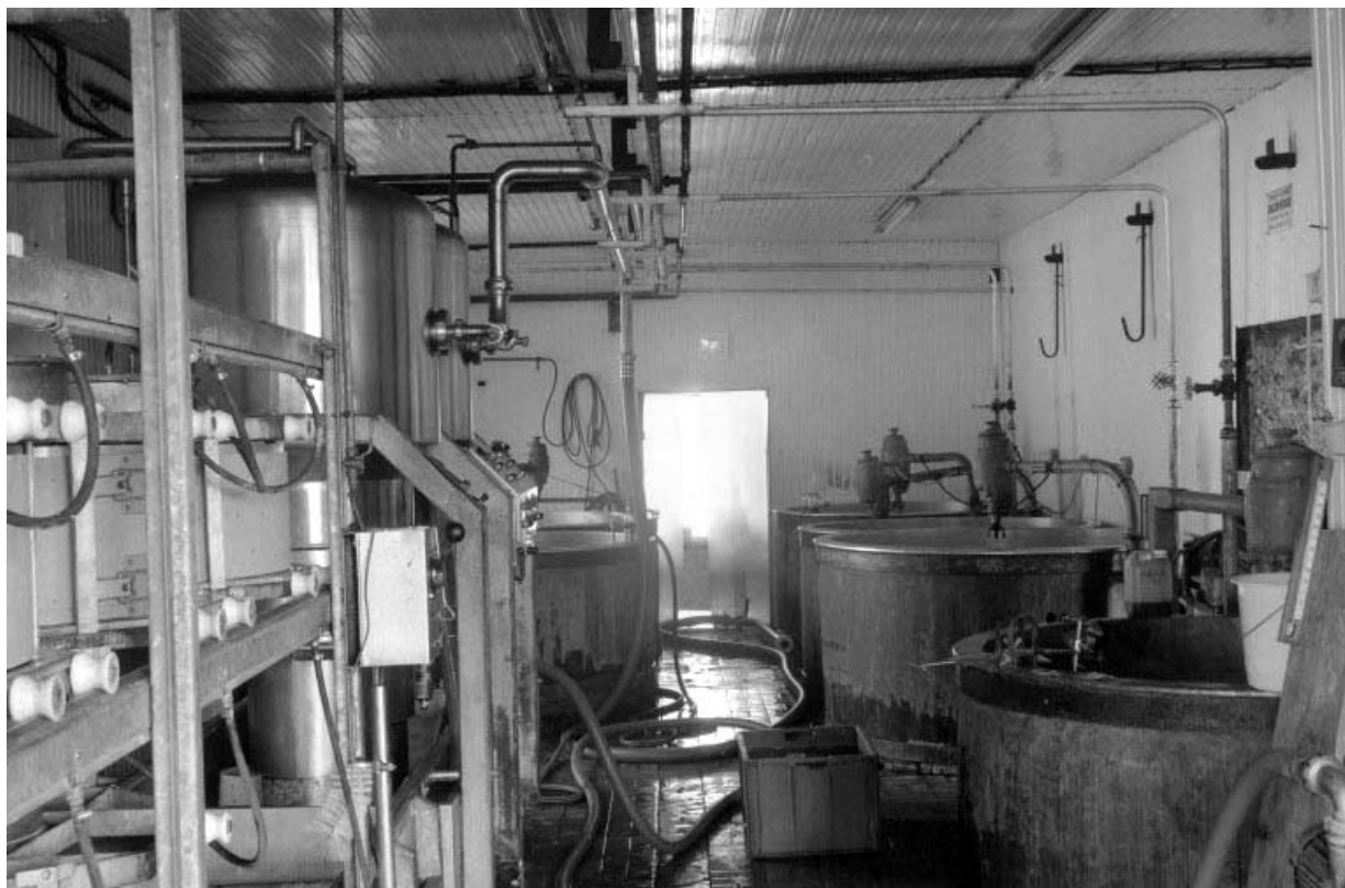
Intérieur de l'atelier de fabrication.
