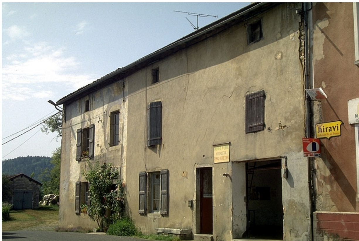
Façade antérieure. 39, Montfleur
