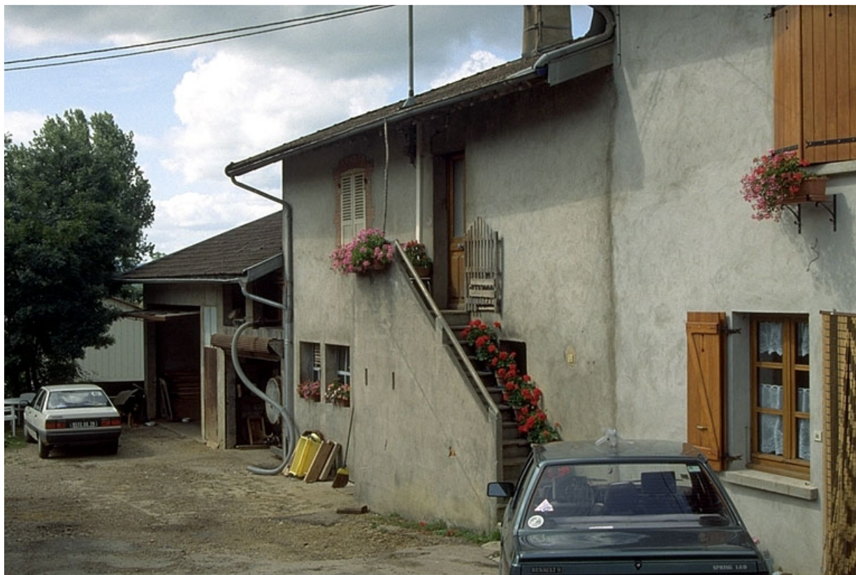
Façade antérieure vue de trois quarts droite. 39, Louvenne
