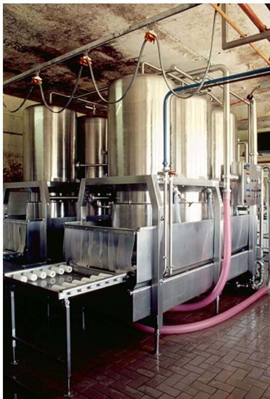
Cloches de l'installation de soutirage sous vide.
