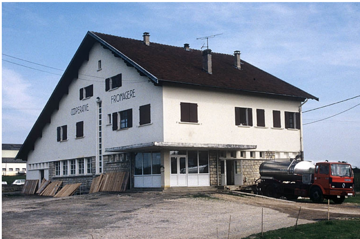
Façades antérieure et latérale gauche.
