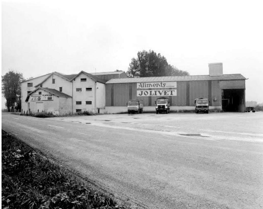
Vue d'ensemble depuis l'ouest. A droite : bâtiment des silos.
