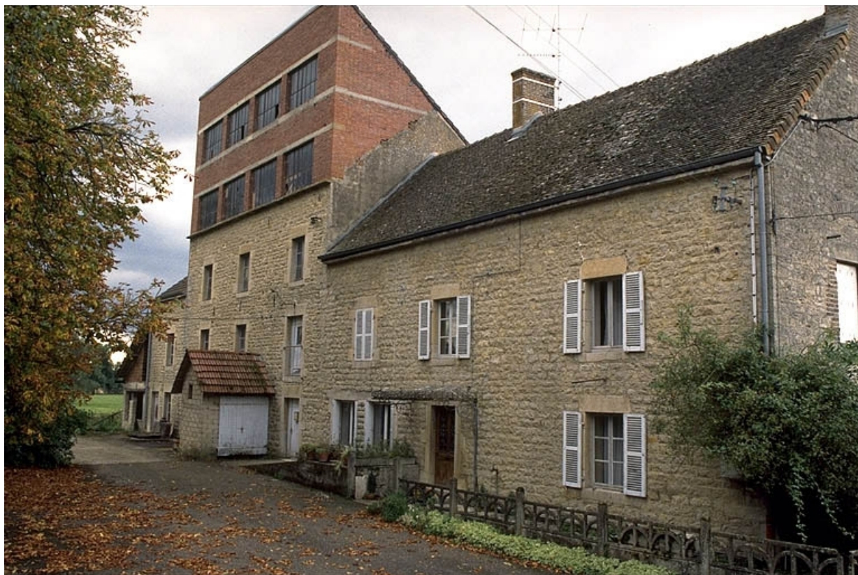
Façade antérieure depuis le nord-est. Atelier de fabrication réhaussé et logement. 39, Cosges rue des Prés Martin
