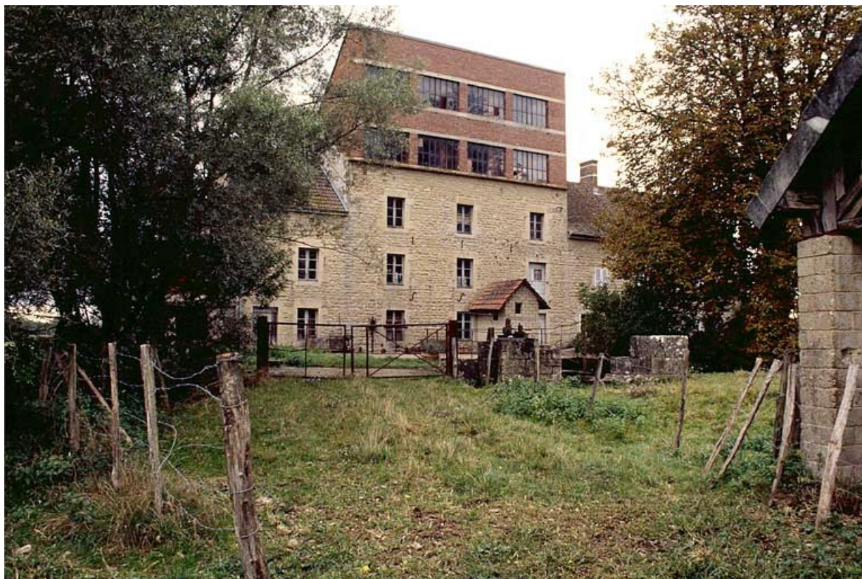
Façade antérieure depuis l'est.
