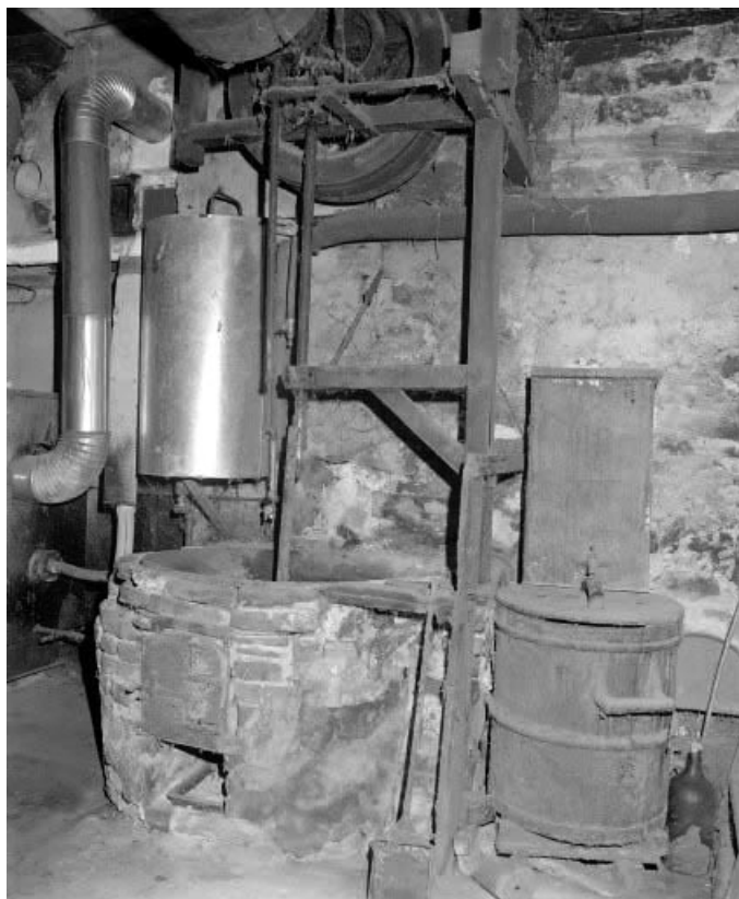
Chaudière. Permet de cuire la mouture sortie des meules.
