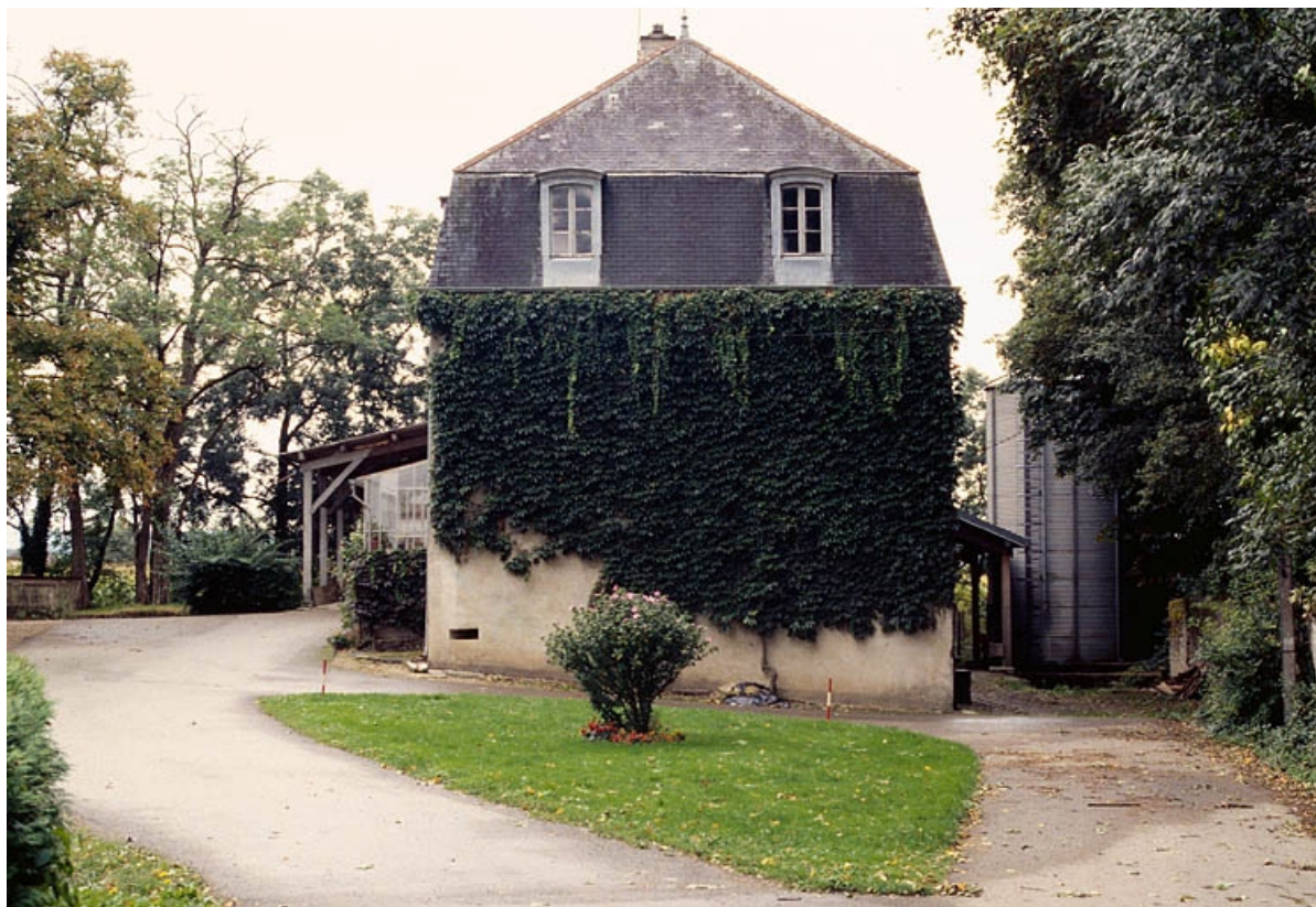
Façade latérale depuis le nord.
