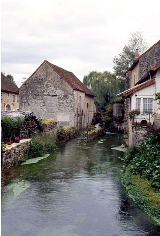
Ancienne huilerie et façade postérieure.
