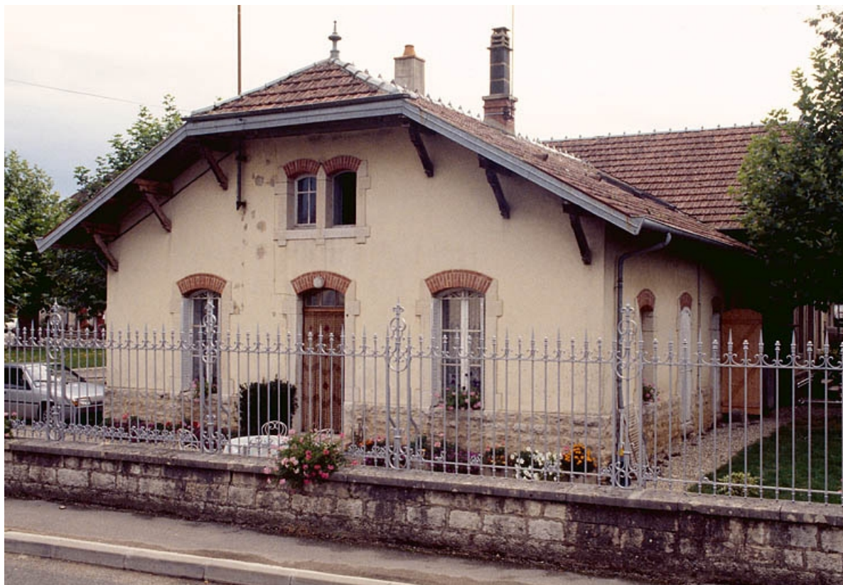
Mur-pignon et façade postérieure depuis l'ouest.
