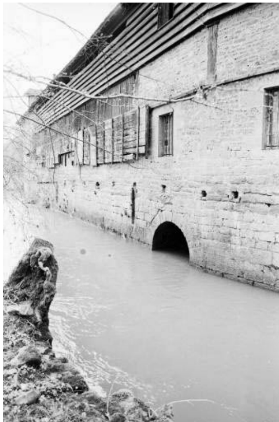
Atelier de fabrication (?) en 1979.Façade sur la Brenne. 39, Toulouse-le-Château chemin de la Vaudrière, lieudit : Baudin
