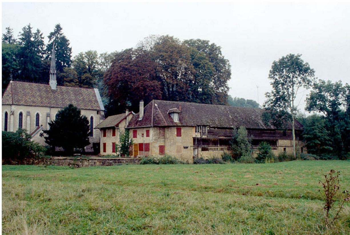
Vue depuis le sud-est. De gauche à droite : chapelle, école et atelier de fabrication le long de la Brenne. 39, Toulouse-le-Château chemin de la Vaudrière, lieudit : Baudin
