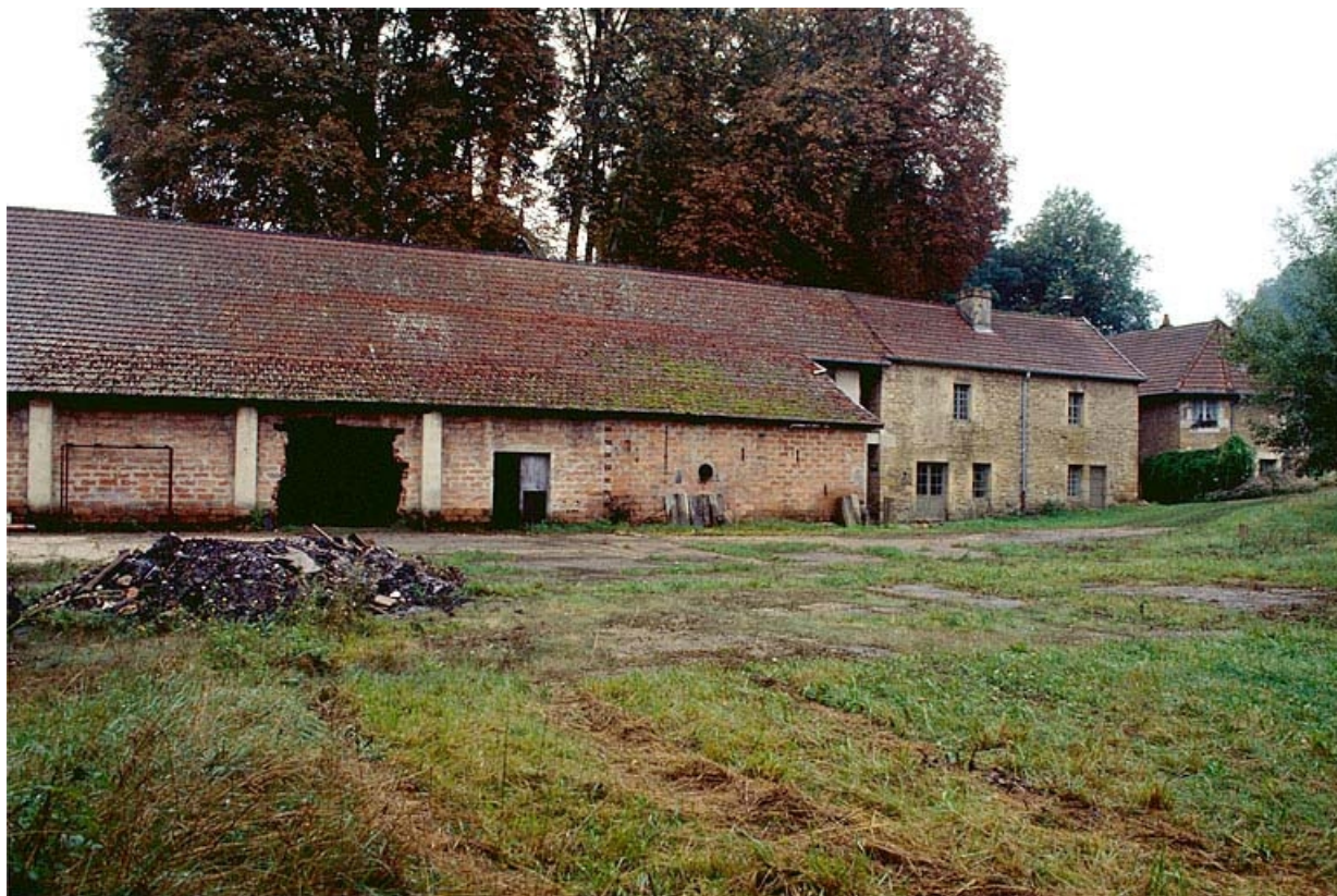
Atelier de fabrication (?), vu depuis le nord.
