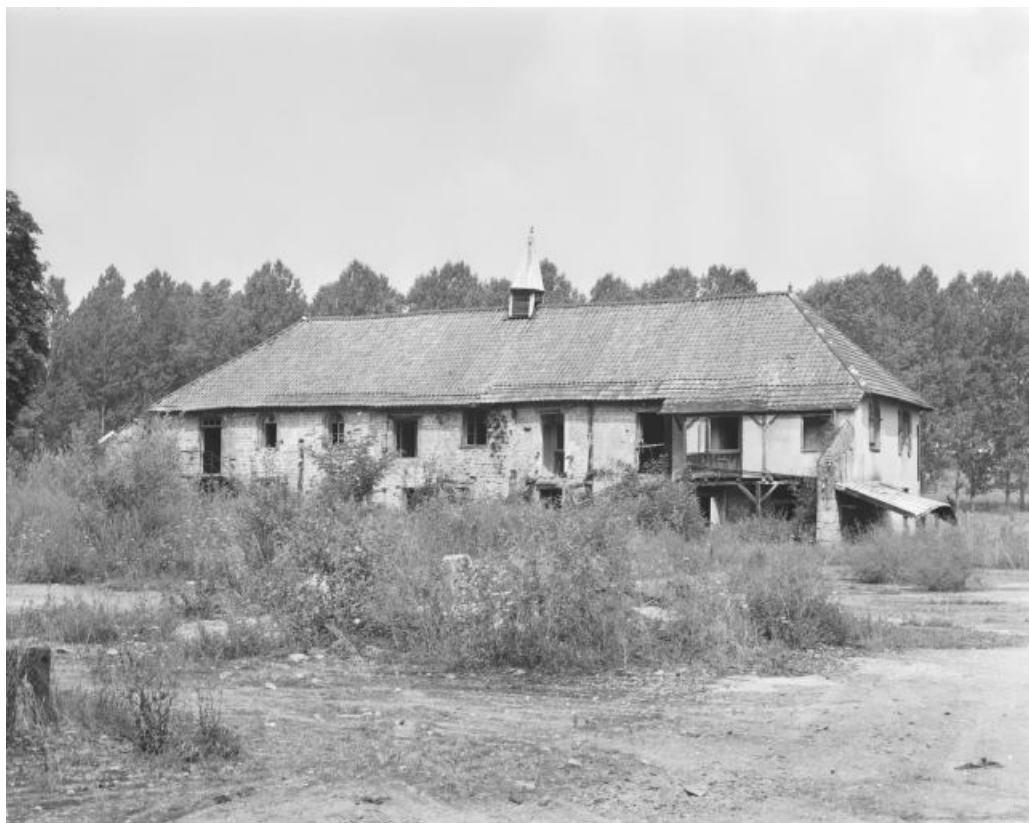
Le presbytère : façade ouest en 1980.
