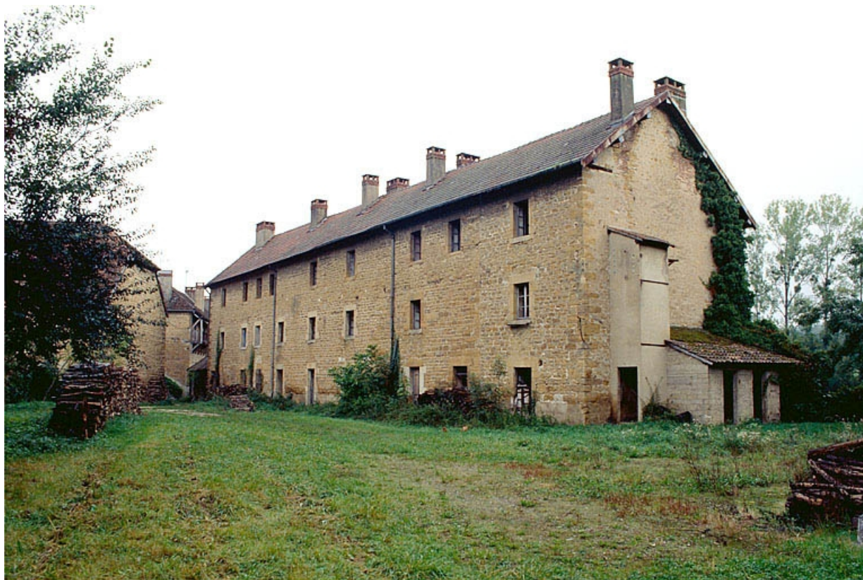
Logement d'ouvriers (D) : façade antérieure vue depuis le sud.
