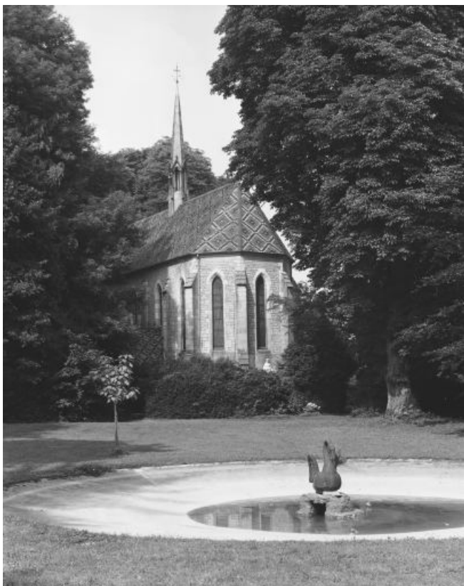
Abside de la chapelle en 1980. Vue depuis le parc au sud-est. 39, Toulouse-le-Château chemin de la Vaudrière, lieudit : Baudin
