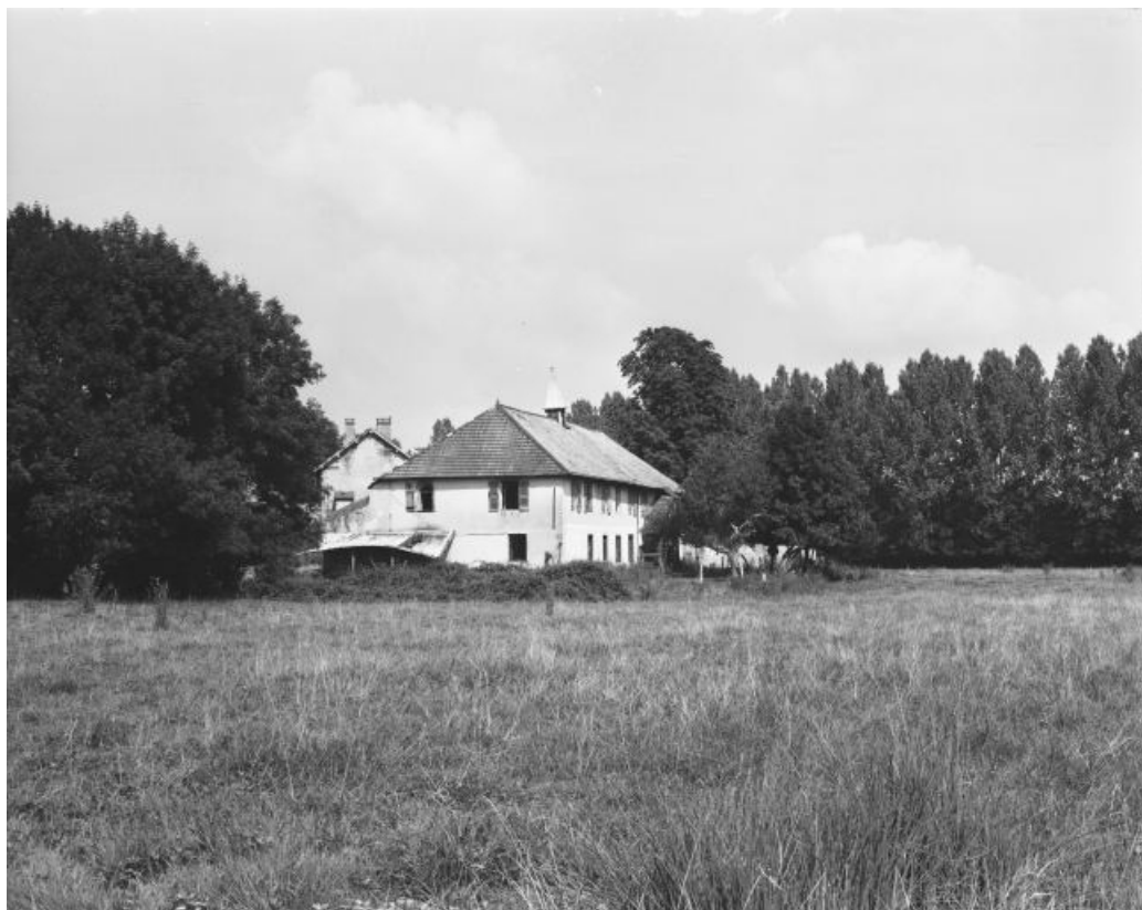
Le presbytère depuis le sud-est.
