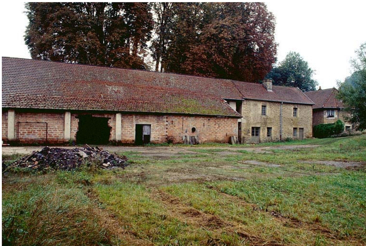
Atelier de fabrication (?), vu depuis le nord.
