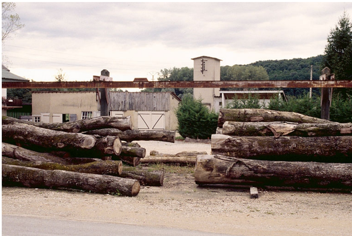
Aire des matières premières. En arrière plan, de gauche à droite : atelier de réparation, remise à automobile, transformateur et ancien bureau.
