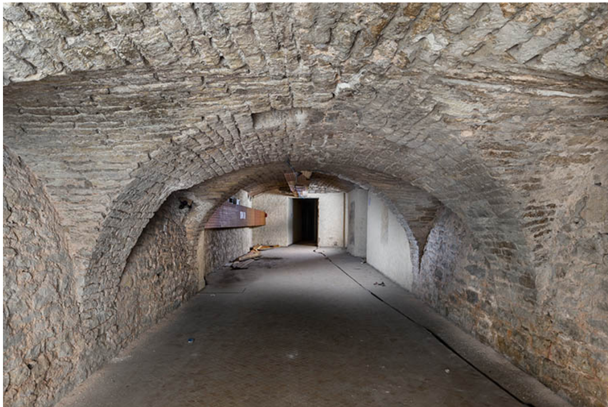
Sous-sol : anciennes caves transformées en couloir pour desservir les salles du cinéma.
