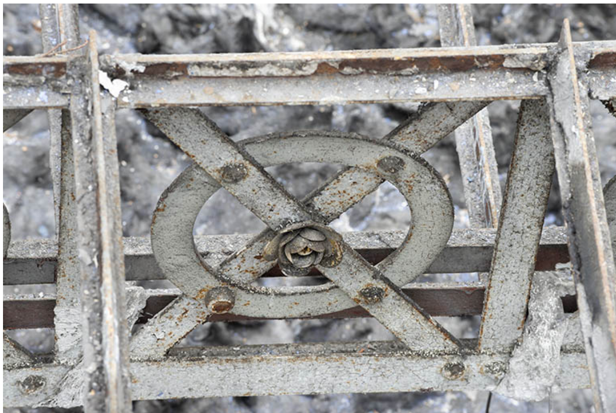
Halle : décor de la charpente métallique.
