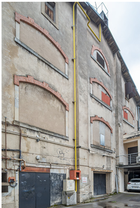
Halle : façade postérieure depuis la cour. 25, Besançon, 60-62 Grande Rue
