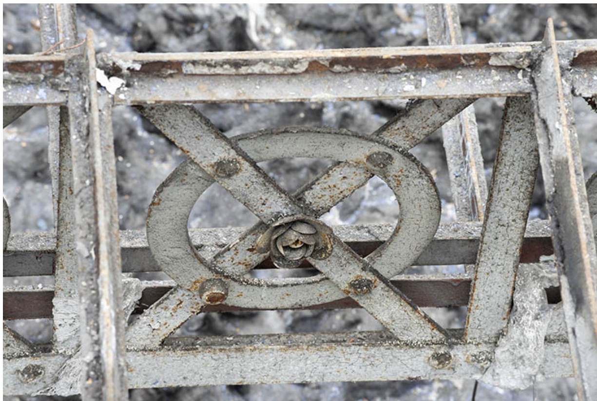
Halle : décor de la charpente métallique.
