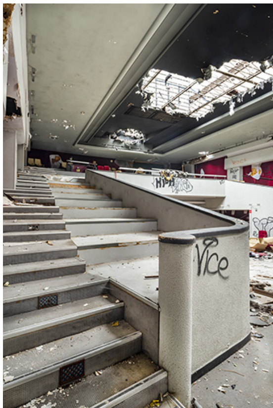
Halle : grande salle, accès au balcon. 25, Besançon, 60-62 Grande Rue
