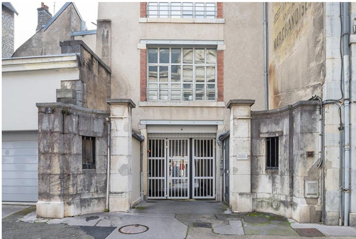
Bâtiment au 5 rue du Palais de Justice : porche et 1er étage.
