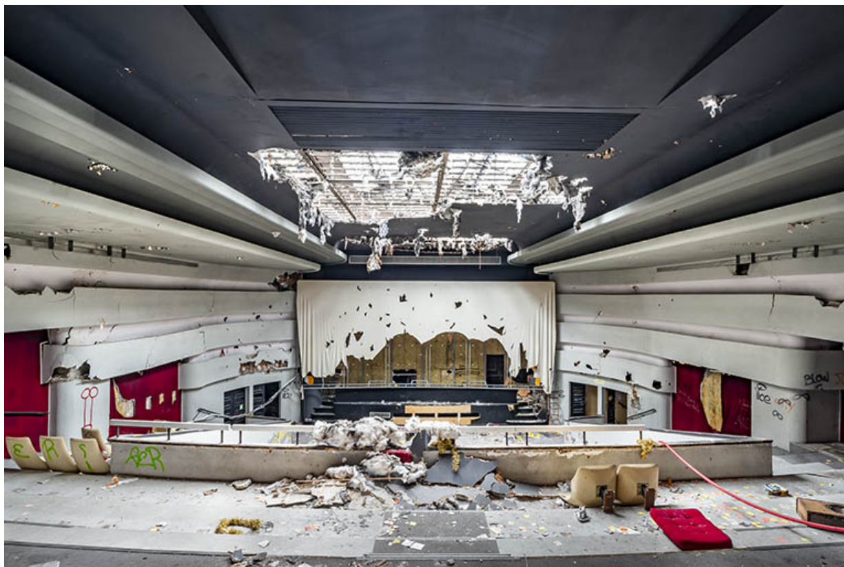
Halle : grande salle, vue depuis le balcon.
