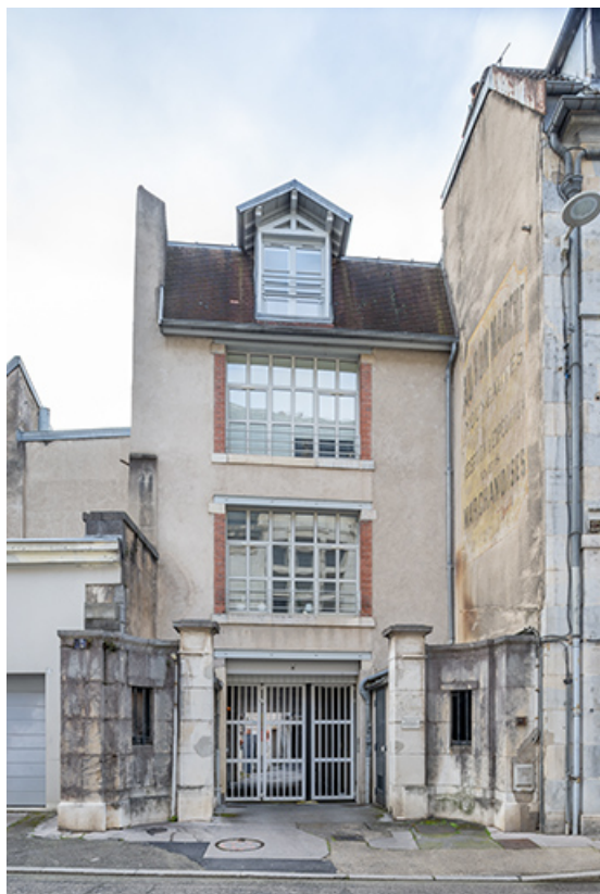
Bâtiment au 5 rue du Palais de Justice.
