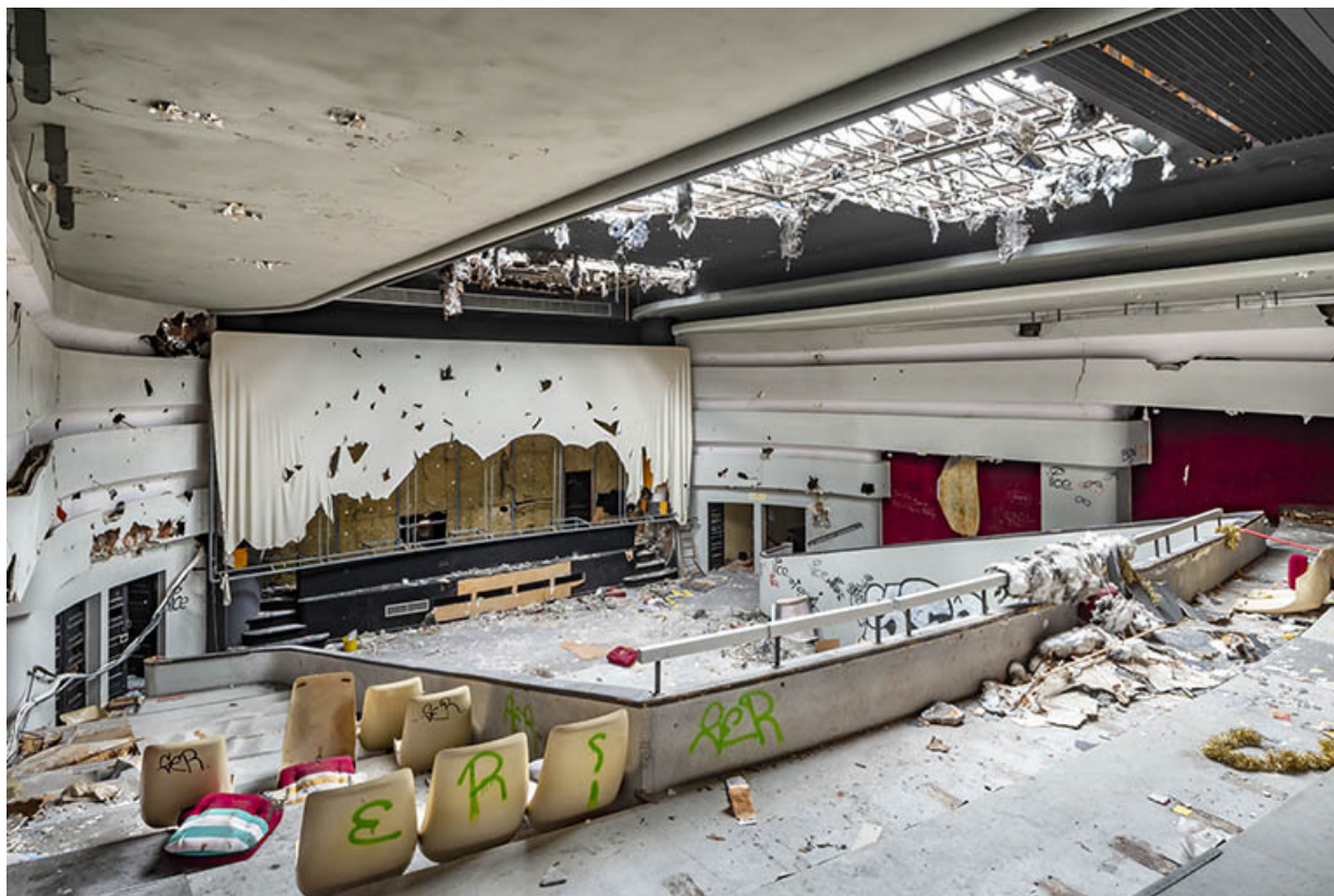
Halle : grande salle, vue depuis le balcon, de trois quarts gauche. 25, Besançon, 60-62 Grande Rue
