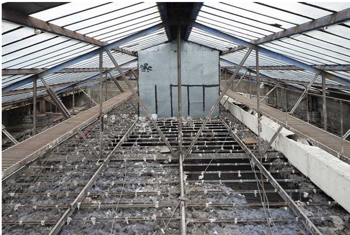
Halle : charpente métallique et verrière.
