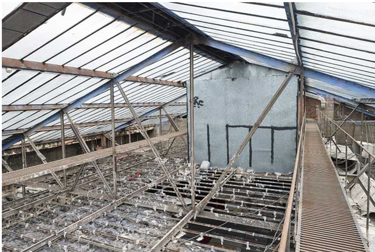
Halle : charpente métallique et verrière, de trois quarts.
