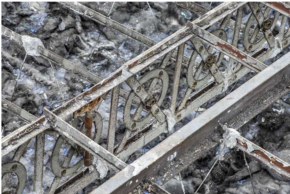
Halle : détail de la charpente métallique.
