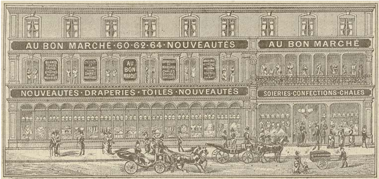
Vue extérieure des magasins du "Bon Marché" à Besançon. S.d. [1895]. 25, Besançon, 60-62 Grande Rue
