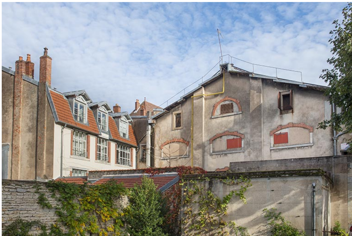
Vue d'ensemble des façades postérieures du bâtiment au 5 rue du Palais de Justice (à gauche) et de la halle (à droite). 25, Besançon, 60-62 Grande Rue
