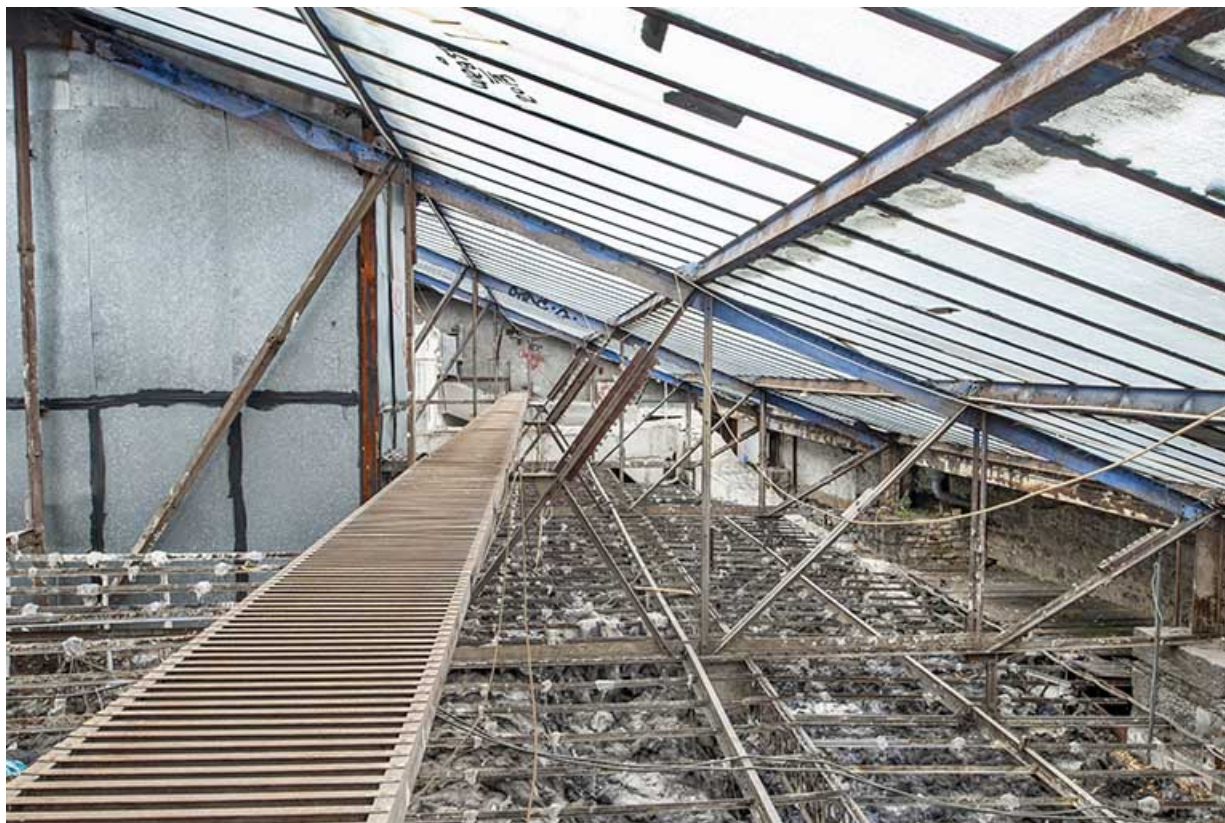
Halle : charpente métallique et passerelle.
