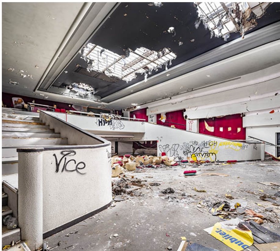
Halle : grande salle, le balcon vu de trois quarts gauche.
