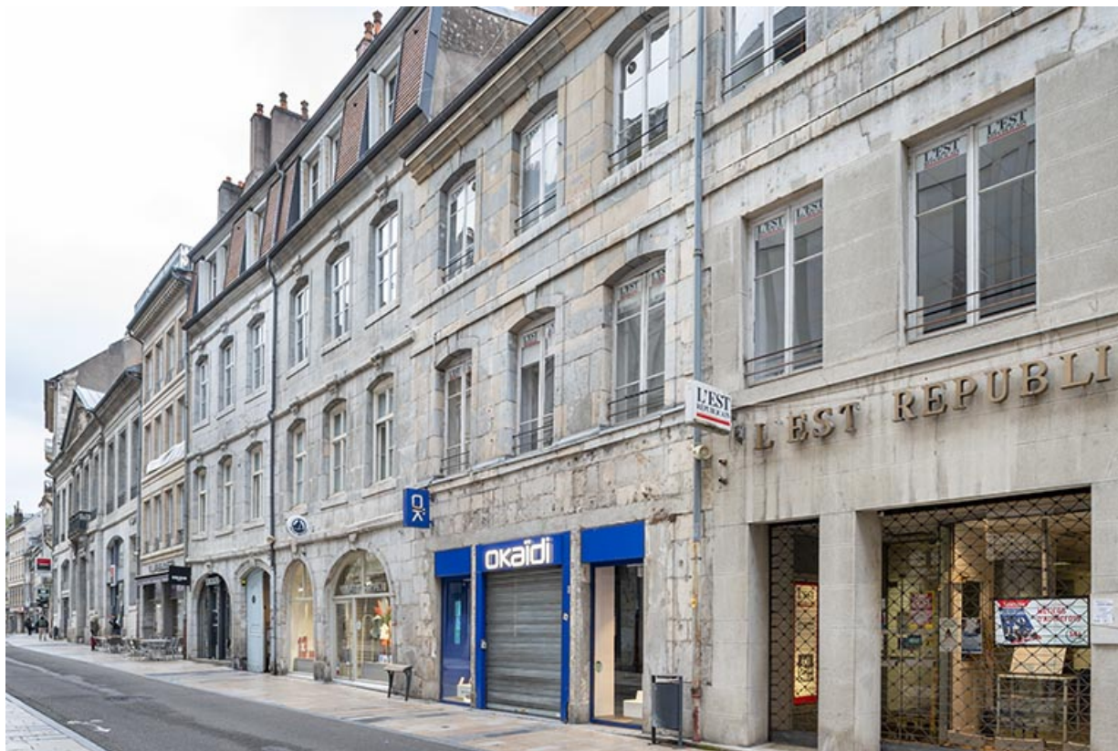
Vue d'ensemble des façades des n° 60 à 64 Grande Rue, de trois quarts droite. 25, Besançon, 60-62 Grande Rue
