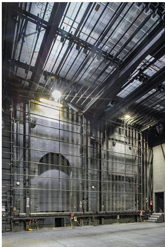
Salle, mur latéral nord-ouest, vue de trois quarts.
