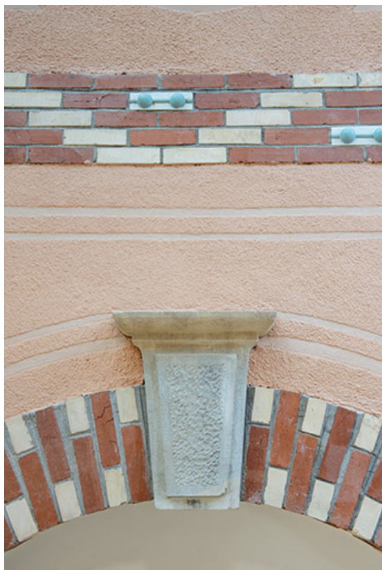
Façade latérale, aujourd'hui donnant dans l'extension de 1993, détail.
