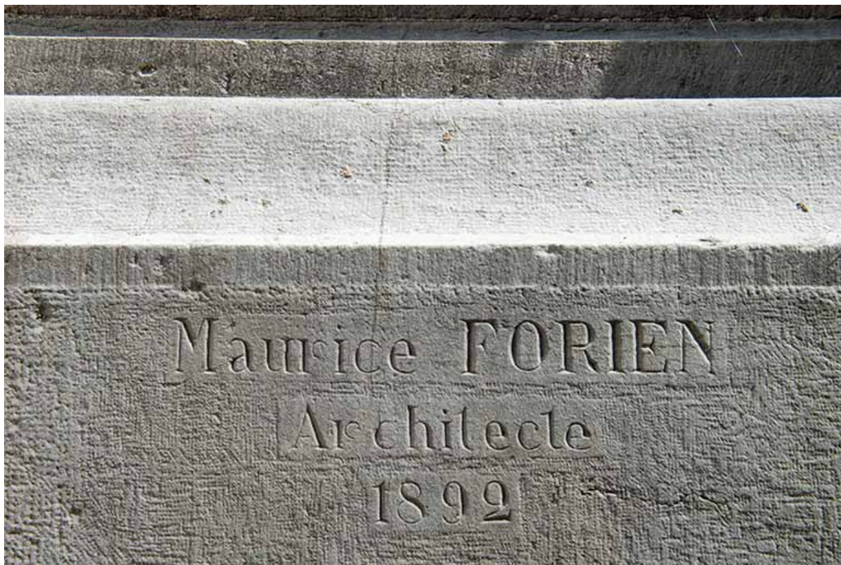
Façade principale, signature : "Maurice FORIEN architecte 1892".
