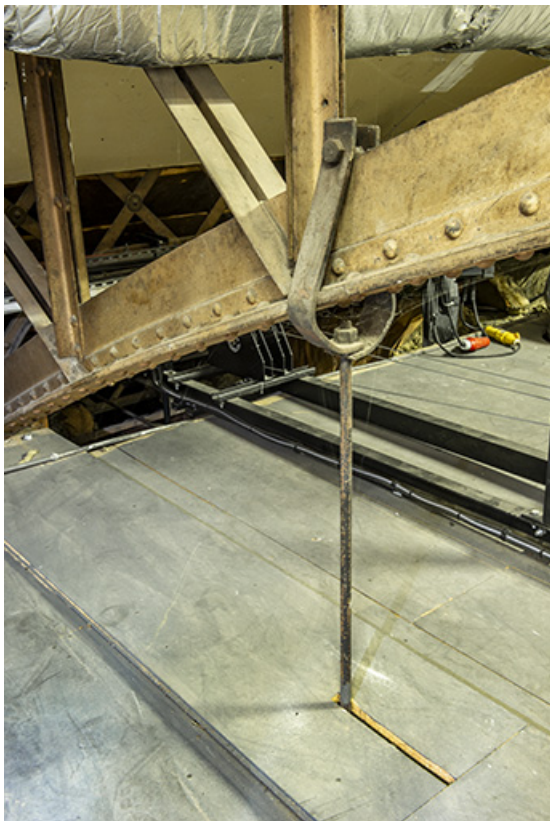
Charpente métallique au-dessus des gradins, étrier de fixation des passerelles. 25, Besançon, 1 esplanade Jean-Luc Lagarce
