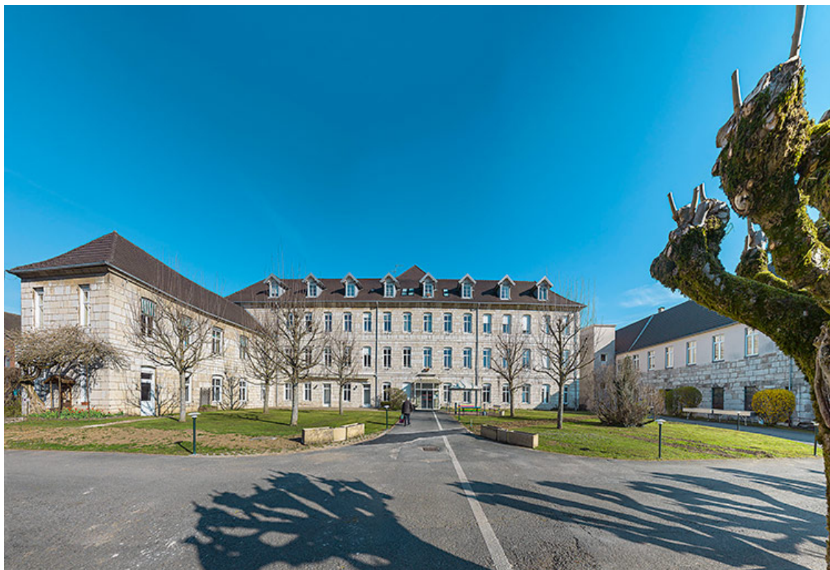
Vue générale du bâtiment construit au 19e siècle.
