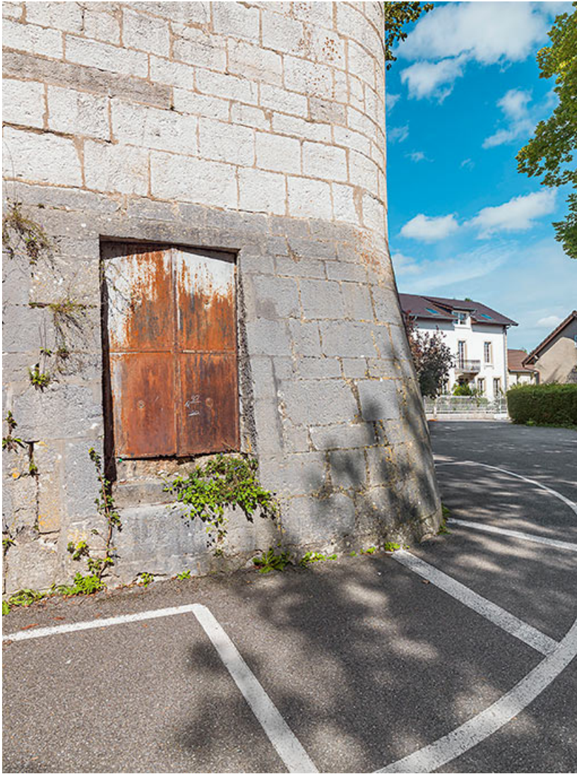
Poterne du demi-bastion.
