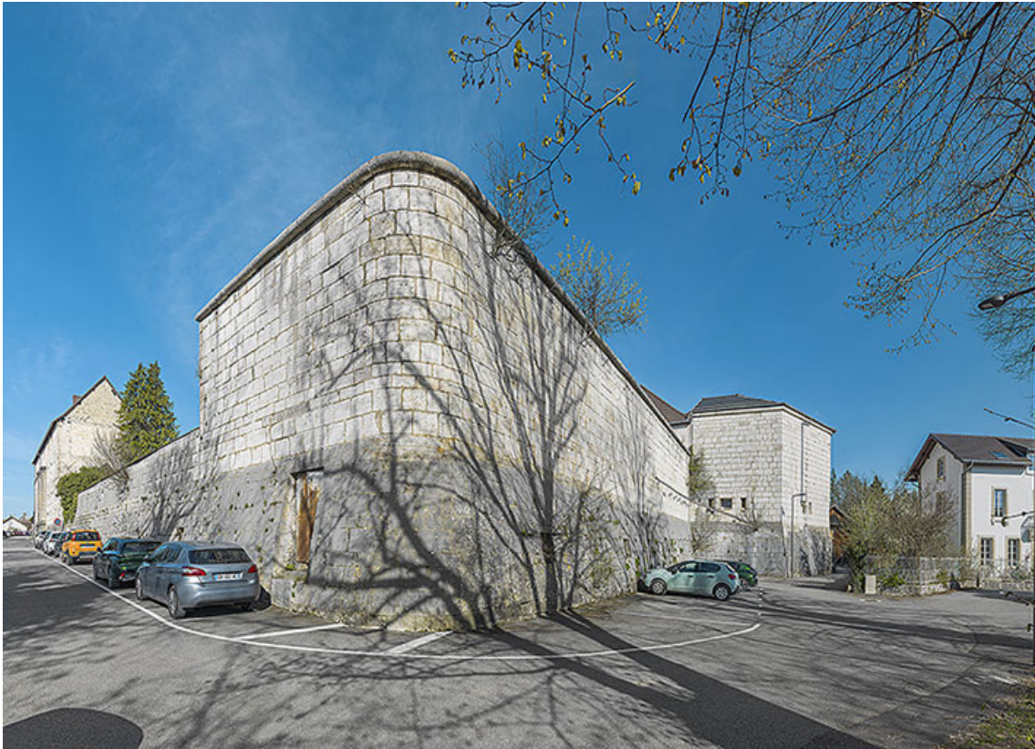
Le front bastionné, vue de trois quarts gauche. 25, Blamont rue Viette
