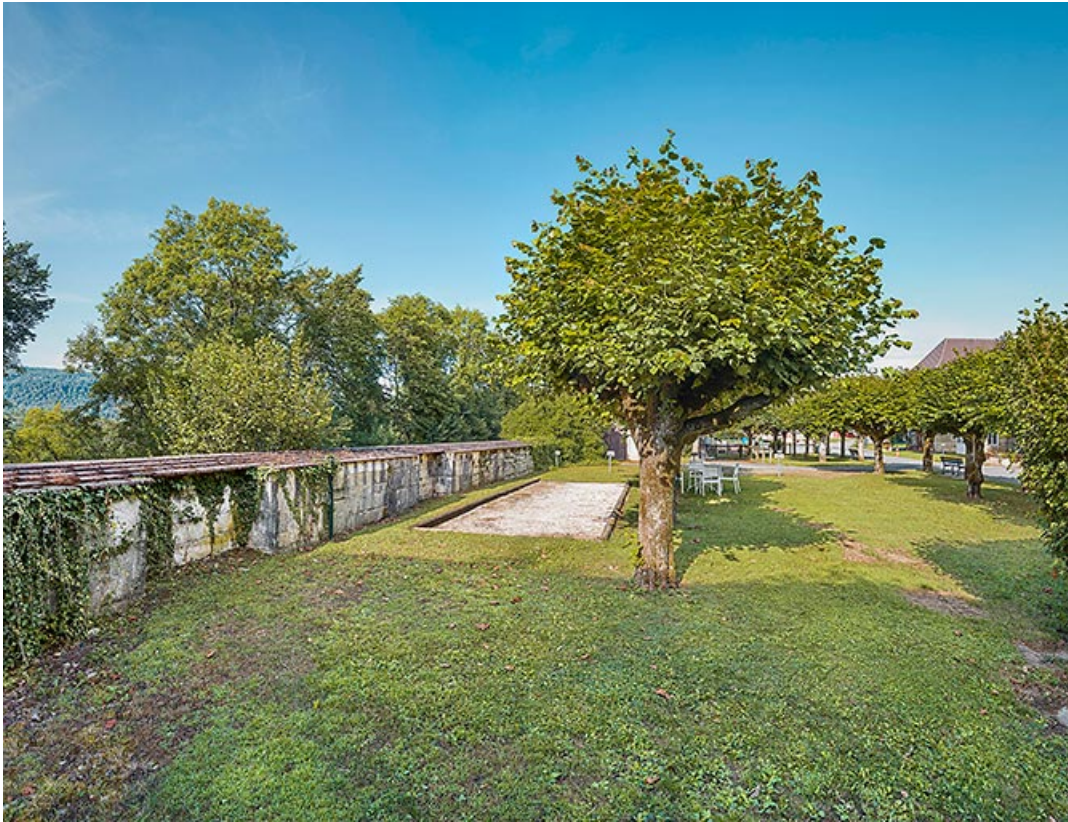
La courtine sud, vue depuis la cour intérieure. 25, Blamont rue Viette
