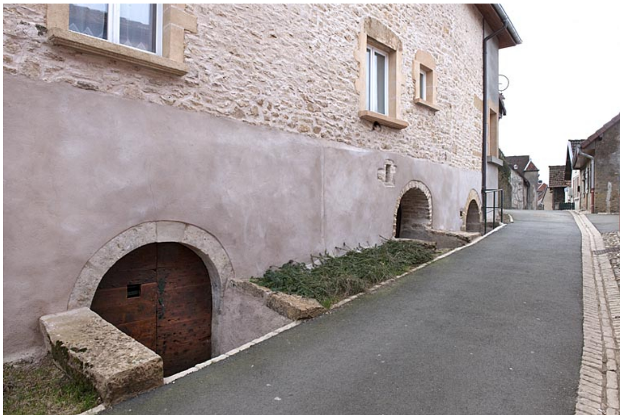
Entrées de cave de la maison à l'angle des rues de la Traverse et de l'Eglise (2010 AL 120). 25, Rougemont
