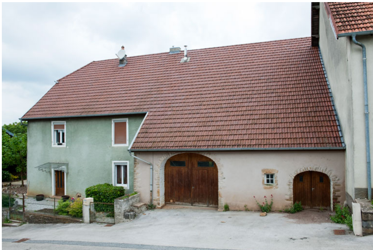
Ferme au 19 rue des Gratteris (2010 AK 55). 25, Rougemont
