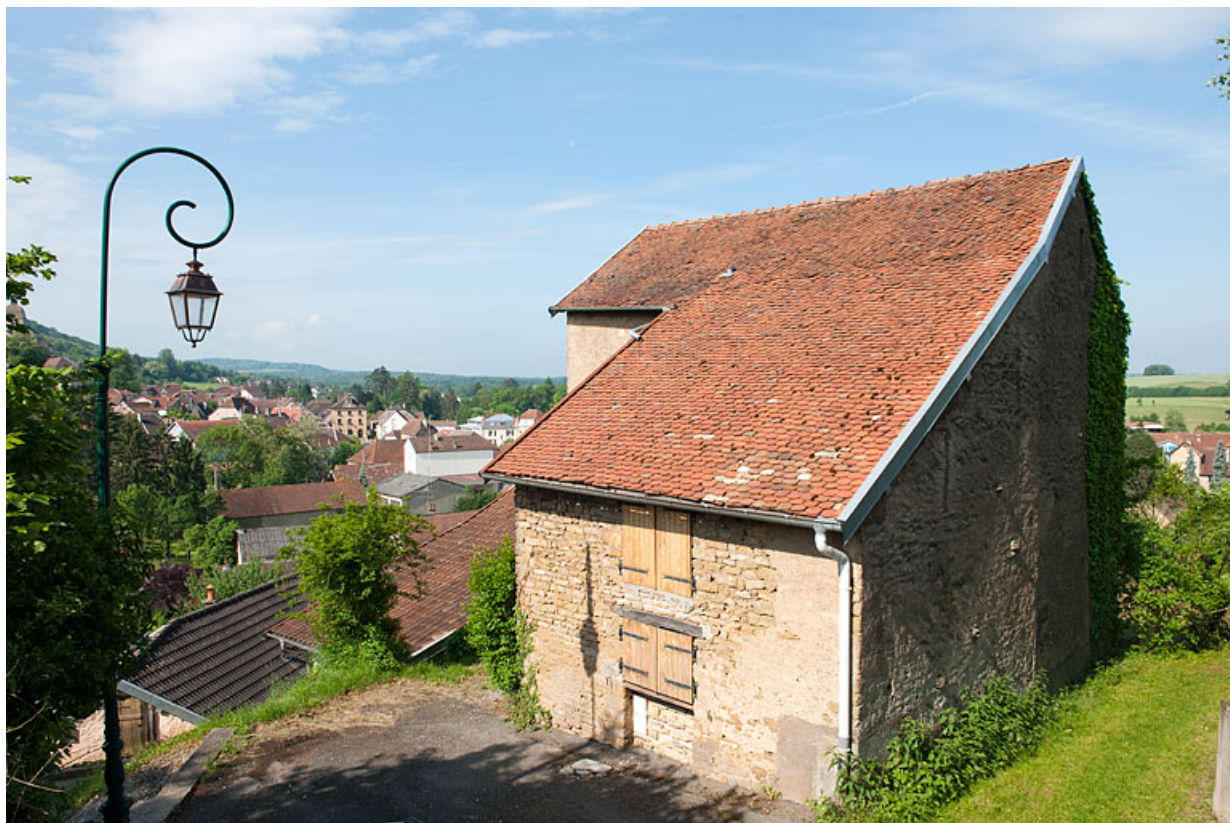
Maison au 3 rue de l'Ancien Cimetière (2010 AK 107). 25, Rougemont
