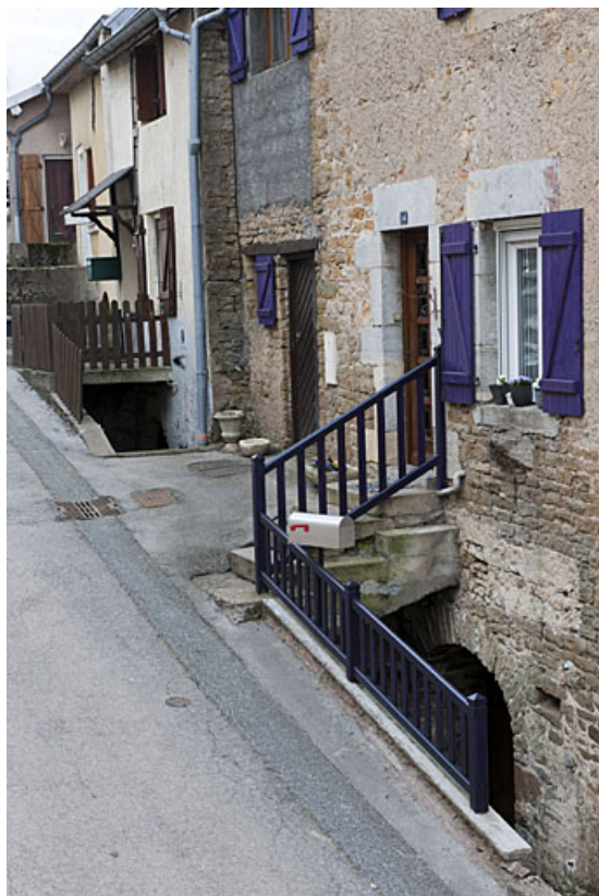
Entrées de cave des maisons aux 14 et 16 rue des Gratteris (2010 AK 110 et 111). 25, Rougemont
