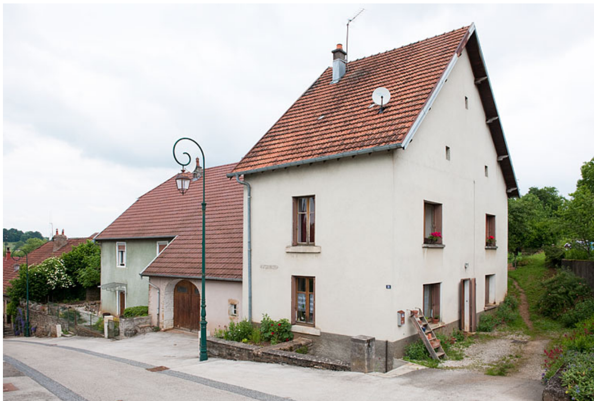
Maison et ferme aux 19 et 21 rue des Gratteris (2010 AK 55 et 58). 25, Rougemont
