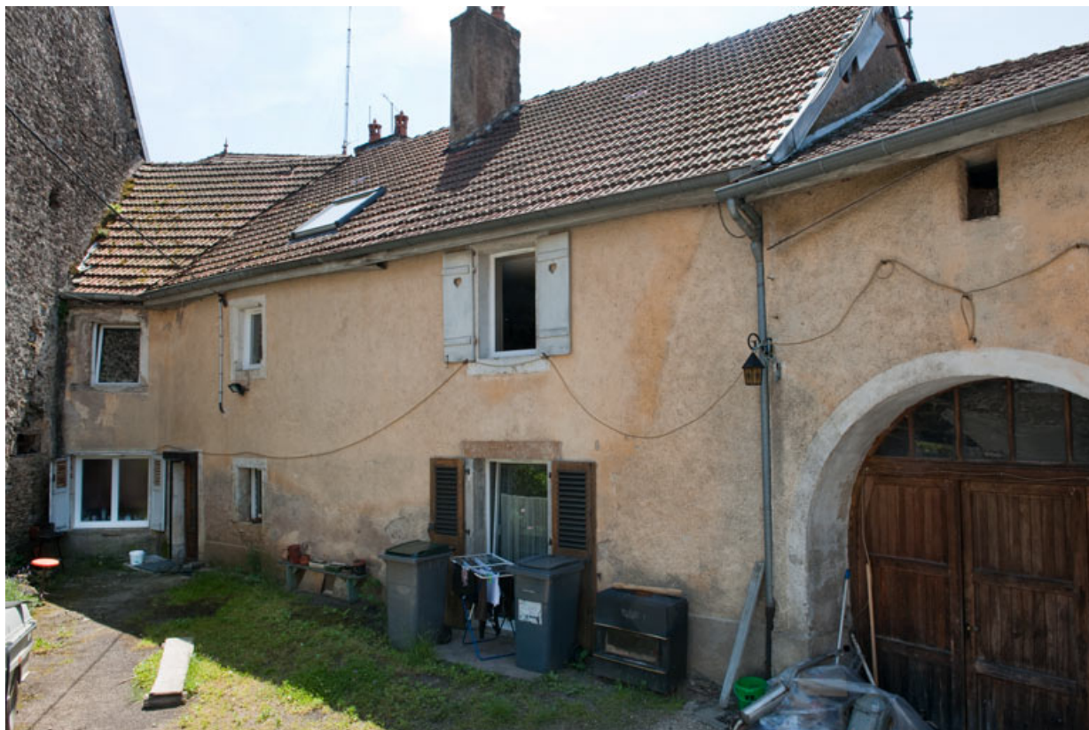
Maison au 18 rue Basse (2010 AL 1). 25, Rougemont
