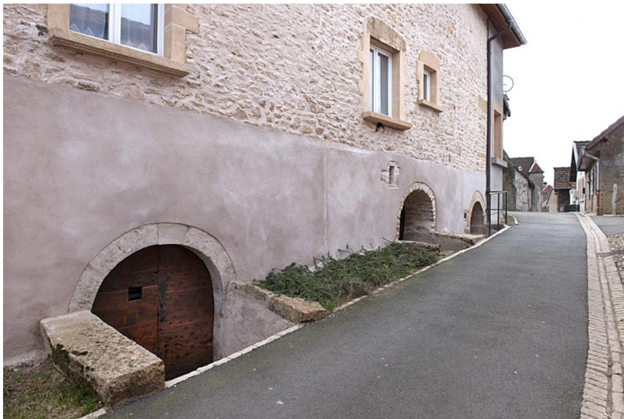
Entrées de cave de la maison à l'angle des rues de la Traverse et de l'Eglise (2010 AL 120). 25, Rougemont
