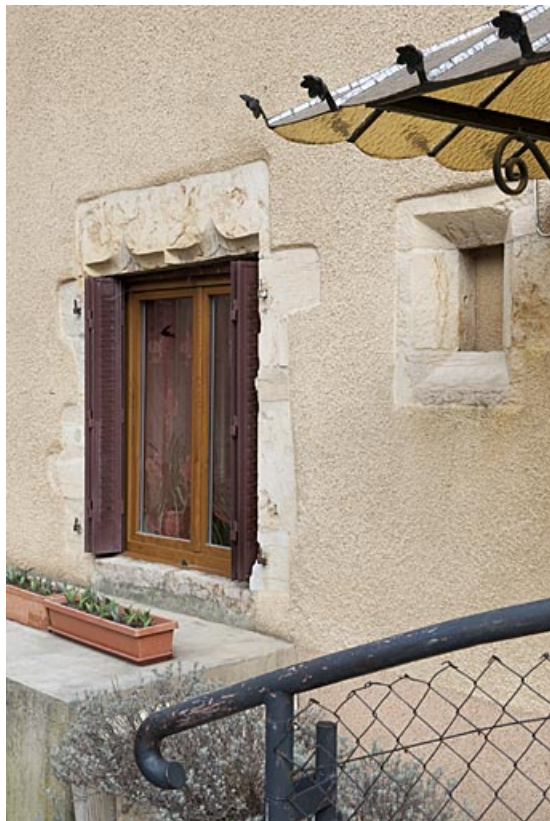
Fenêtre à linteau en arc en accolade de la maison au 12 Grande Rue (2010 AL 47). 25, Rougemont
