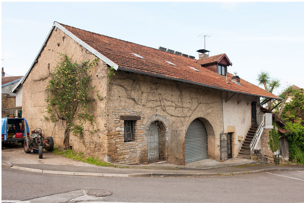
Ferme au 2 rue Maurice Demeusy (2010 AL 416). 25, Rougemont
