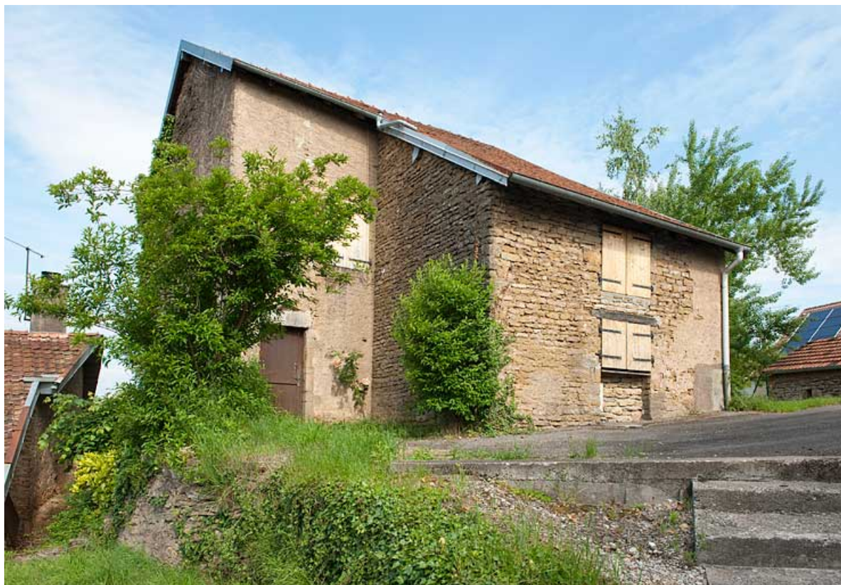
Maison au 3 rue de l'Ancien Cimetière (2010 AK 107). 25, Rougemont
