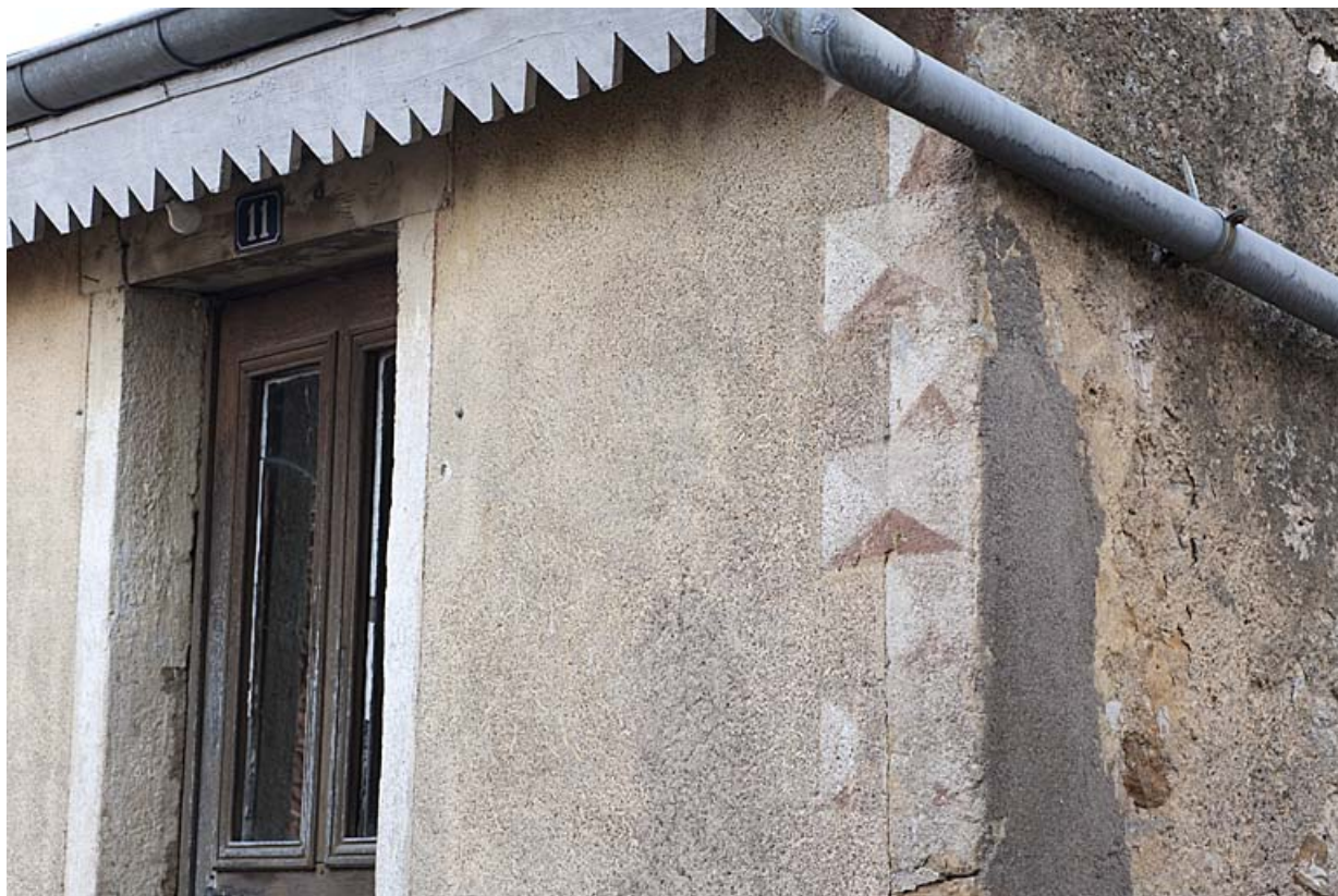
Décor en "pointe de diamant" peint en façade de la maison au 11 rue des Gratteris (2010 AK 48). 25, Rougemont
