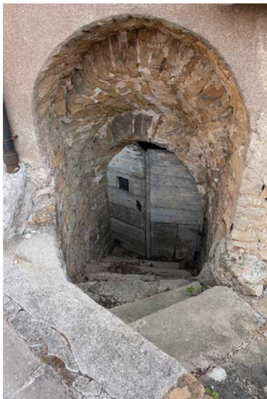
Entrée de cave de la maison au 10 rue de la Grande Côte (2010 AL 77). 25, Rougemont
