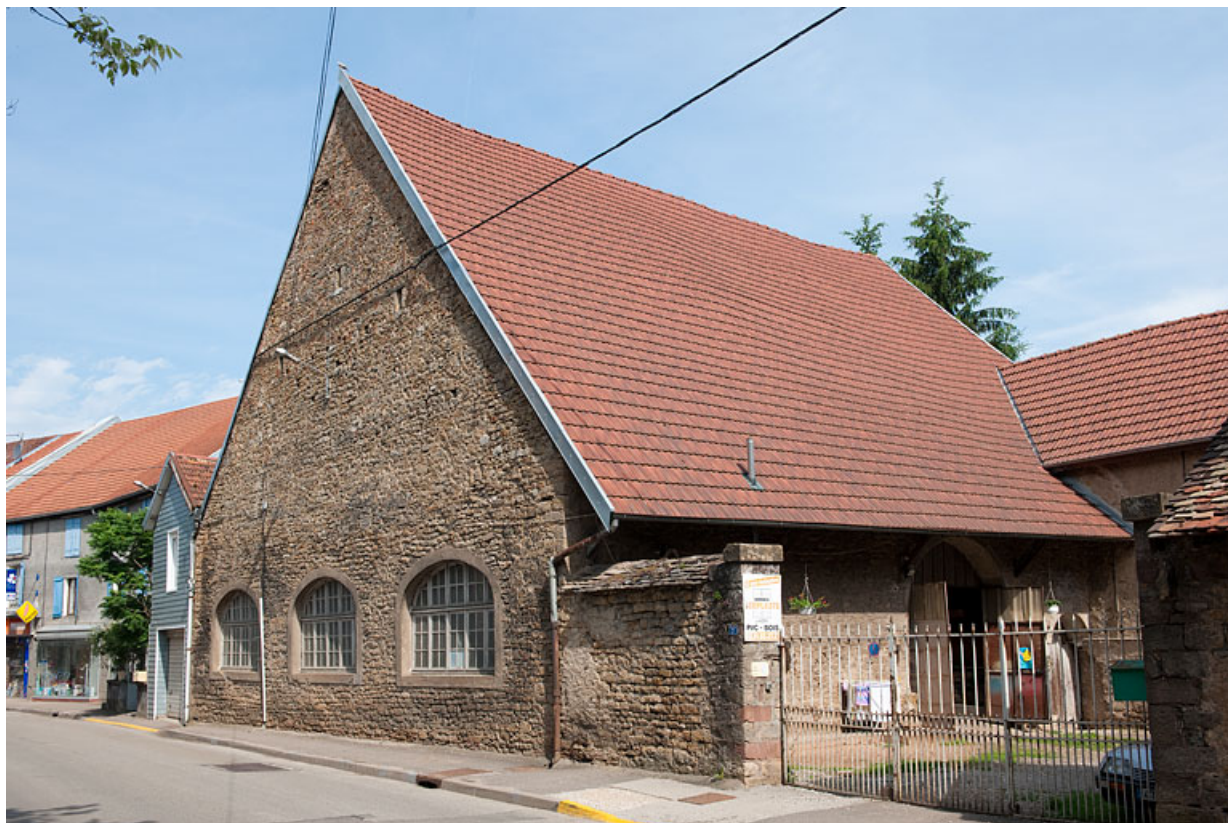
Ferme au 7 rue du Vieux Moulin (2010 AK 187) : la grange. 25, Rougemont
