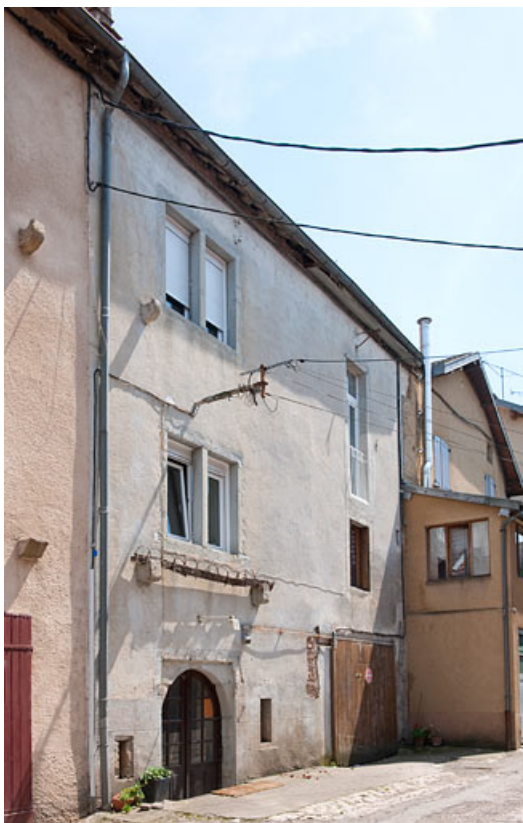
Ferme au 10 Grande Rue (2010 AL 46) : façade postérieure (rue Basse). 25, Rougemont
