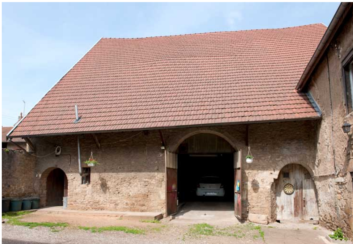
Ferme au 7 rue du Vieux Moulin (2010 AK 187) : la grange vue de face. 25, Rougemont
