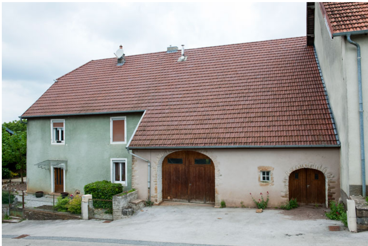
Ferme au 19 rue des Gratteris (2010 AK 55). 25, Rougemont
