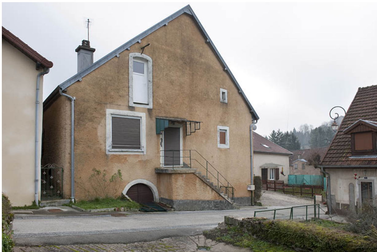
Maison au 4 rue des Gratteris (2010 AK 118) : façade antérieure. 25, Rougemont
