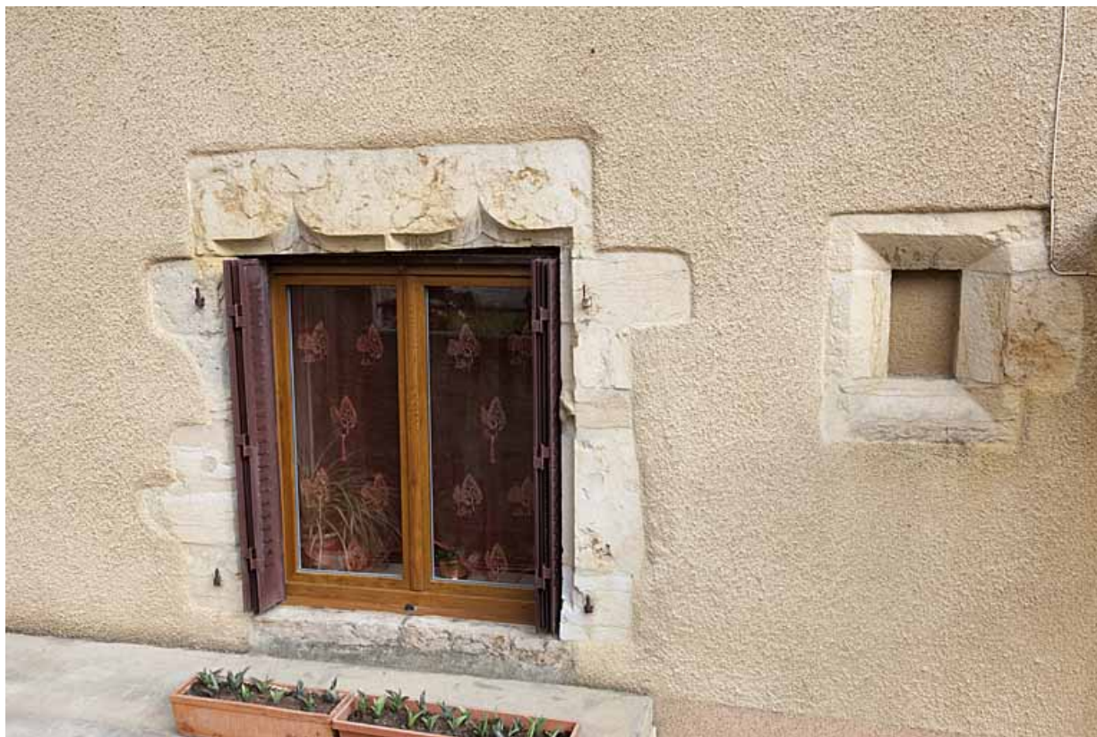
Fenêtre à linteau en arc en accolade de la maison au 12 Grande Rue (2010 AL 47). 25, Rougemont
