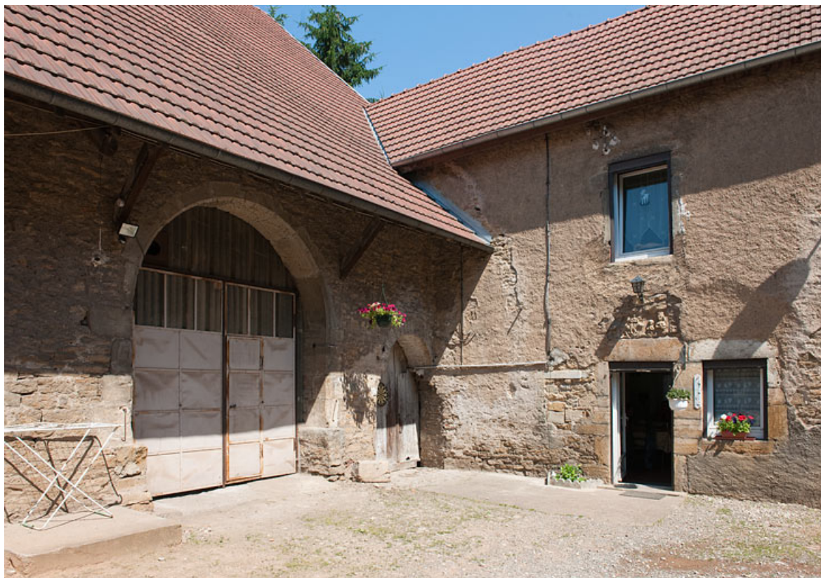
Ferme au 7 rue du Vieux Moulin (2010 AK 187) : grange et logis. 25, Rougemont
