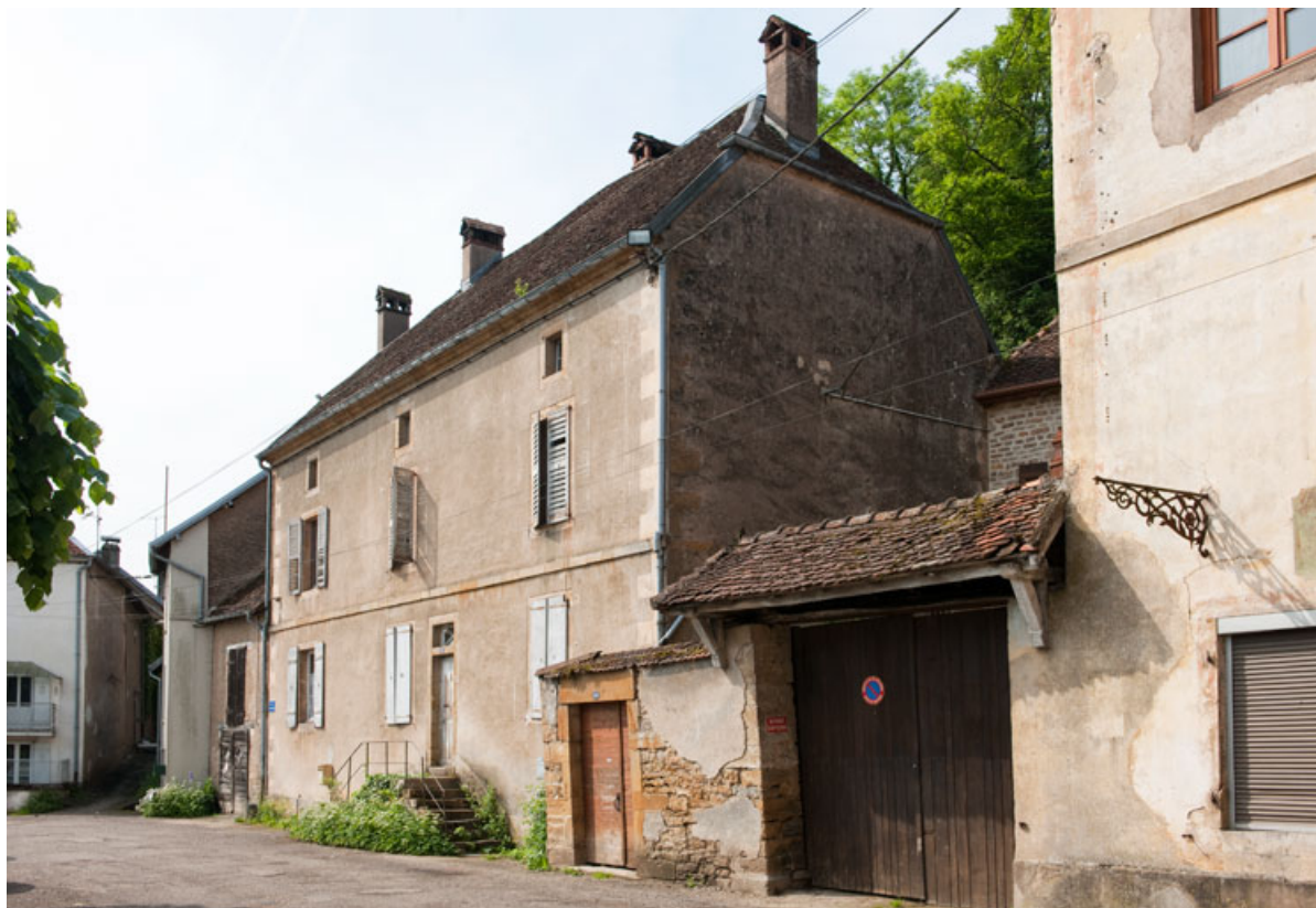
Maison au 26 rue du Vieux Moulin (2010 AL 164). 25, Rougemont
