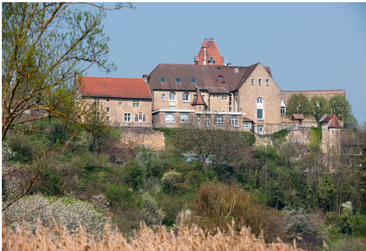
Vue d'ensemble rapprochée.
