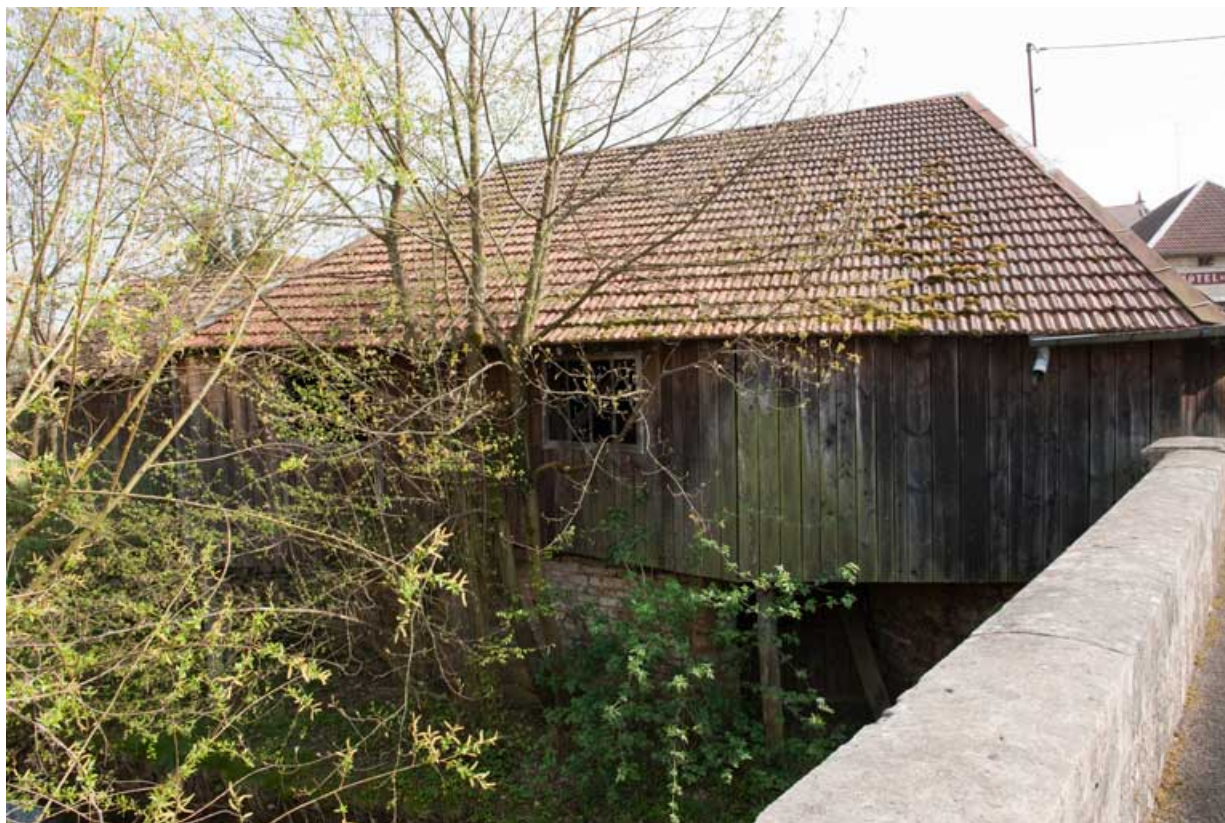
Scierie Courtot, rue du Pont : façade postérieure (côté Drigeon). 25, Rougemont
