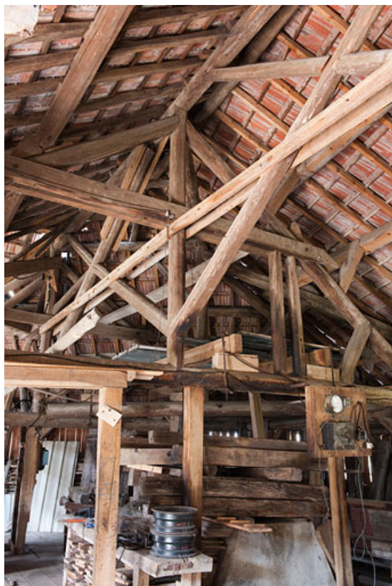
Scierie Courtot, rue du Pont : charpente. 25, Rougemont
