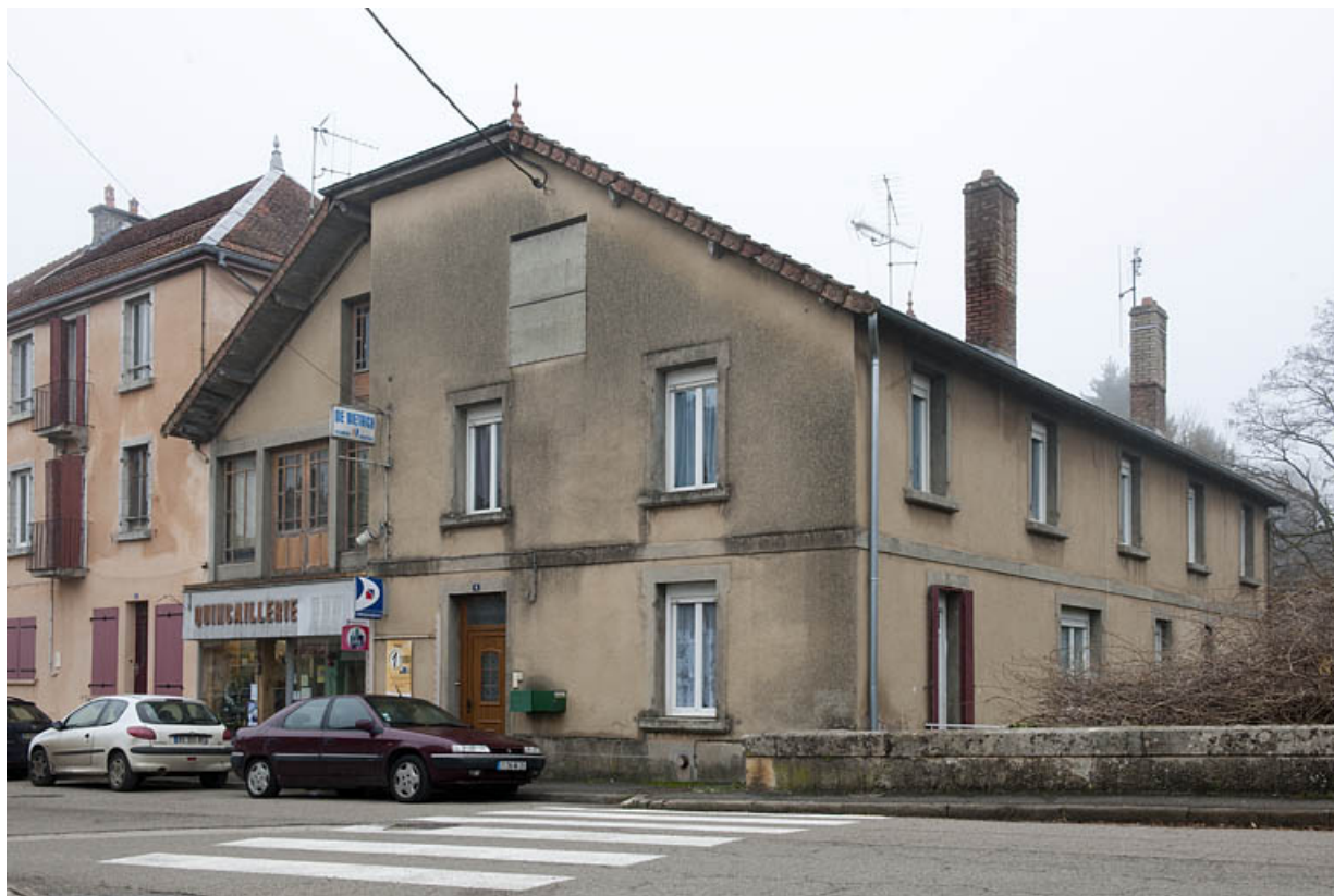
Maison et magasin de commerce au 6 rue du Pont (2010 AK 180). 25, Rougemont
