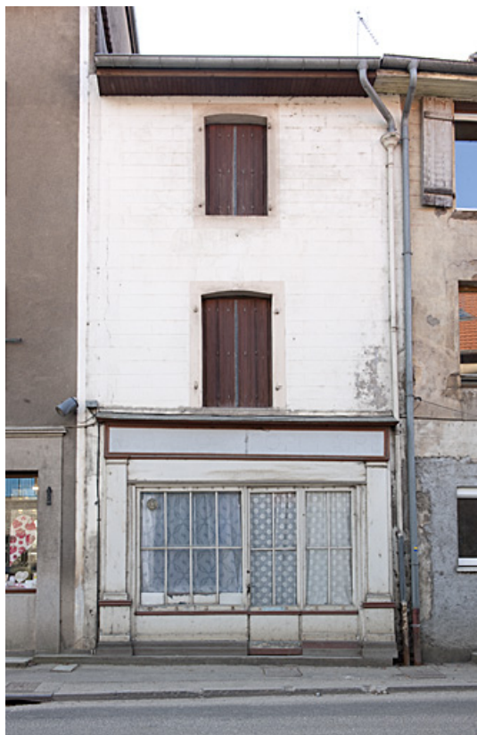
Ancien magasin de commerce au 8 rue du Vieux Moulin (2010 AL 136). 25, Rougemont
