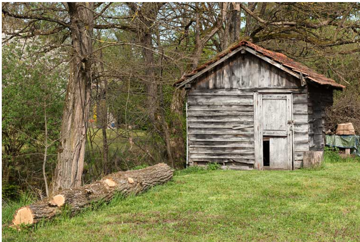
Scierie Courtot, rue du Pont : dépendance en pan de bois et essentage de planches. 25, Rougemont
