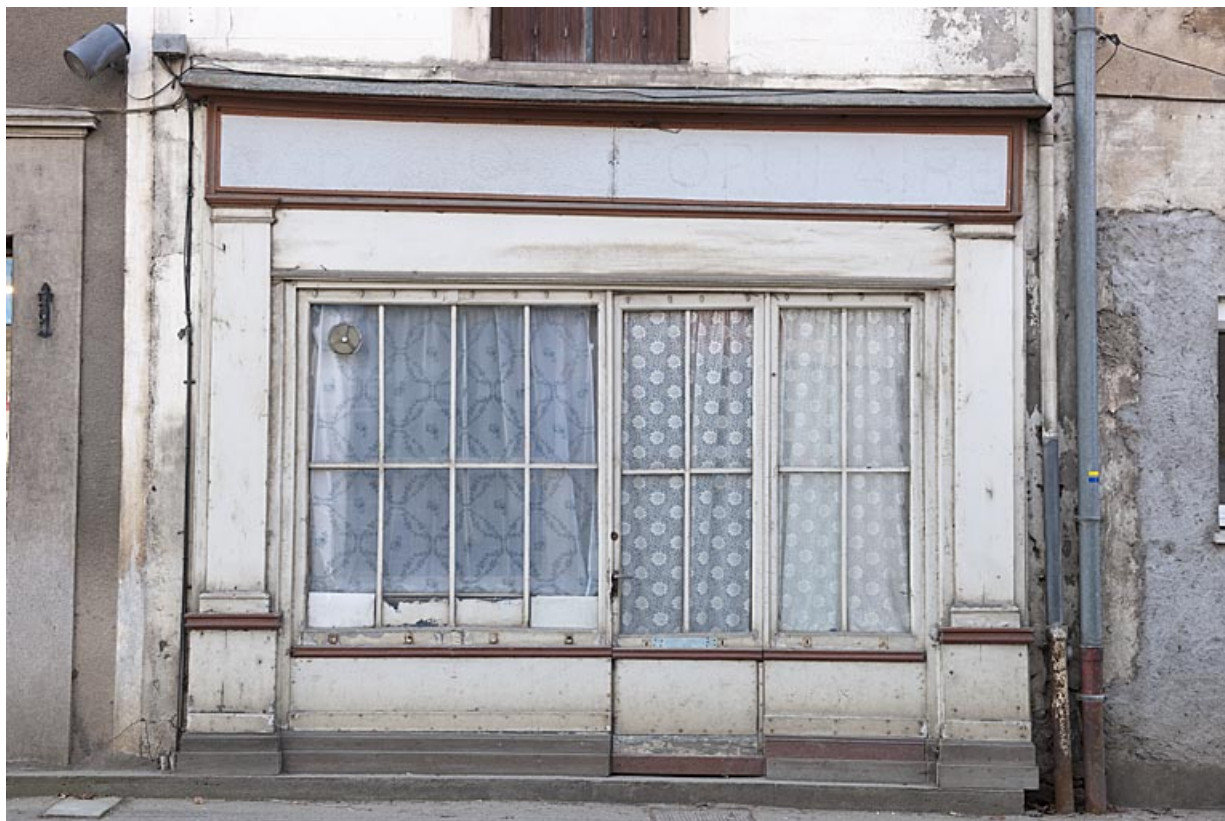
Ancien magasin de commerce au 8 rue du Vieux Moulin (2010 AL 136) : devanture. 25, Rougemont
