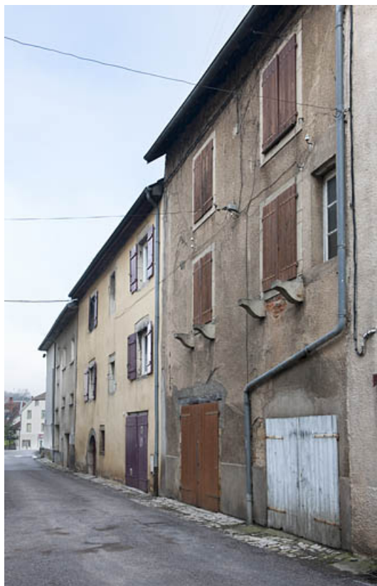
La rue Basse, vers la mairie. 25, Rougemont
