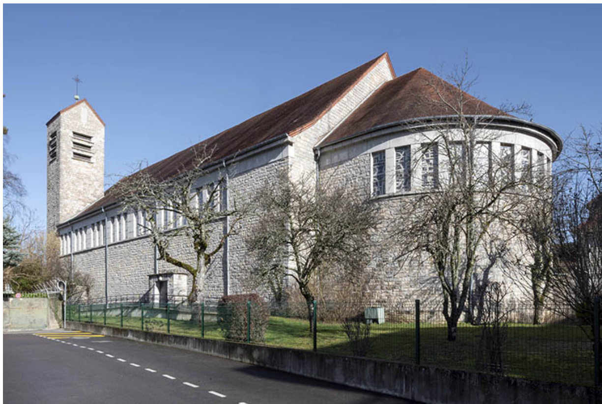
Chevet, façade latérale ouest et clocher de l'église.
