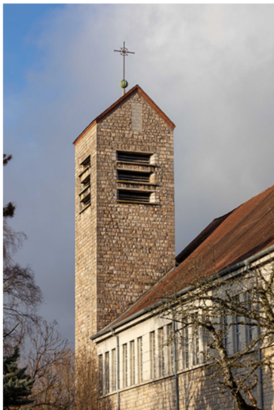
Vue du clocher depuis le côté sud-ouest de l'église.
