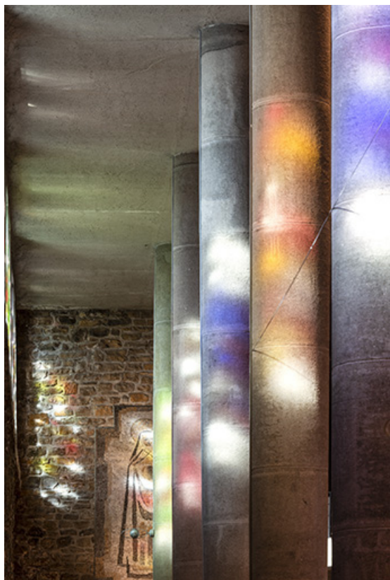
Détail des piliers et du reflet des dalles de verre dans la nef.
