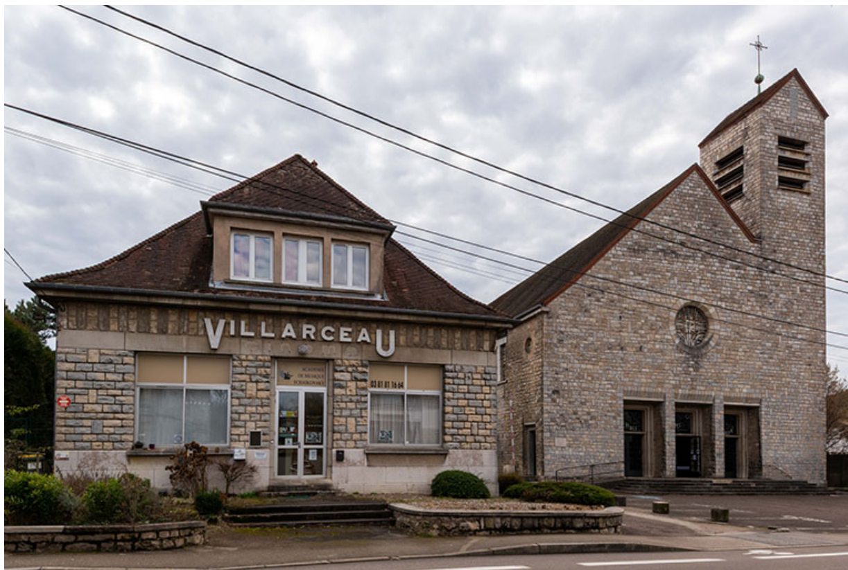
Façades nord de la maison des œuvres - cinéma Villarceau et de l'église Saint-Joseph. 25, Besançon, 18 avenue Villarceau
