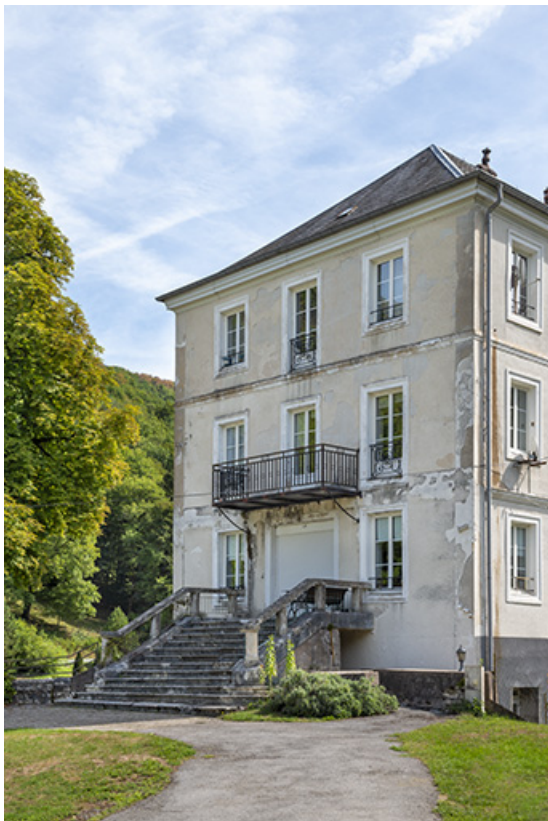
Extension ouest construite vers 1900-1910, vue de trois quarts.
