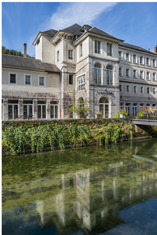
Façade principale, vue de trois quarts, détail.
