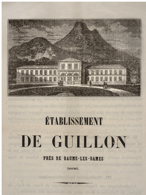
Vue de l'établissement thermal vers 1850 : le "bâtiment neuf". 25, Guillon-les-Bains route départementale 21, lieudit : les Bains
