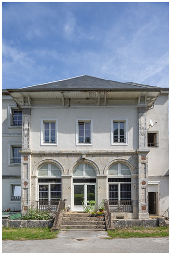
Façade arrière, vue de face, détail : avant-corps central. 25, Guillon-les-Bains route départementale 21, lieudit : les Bains
