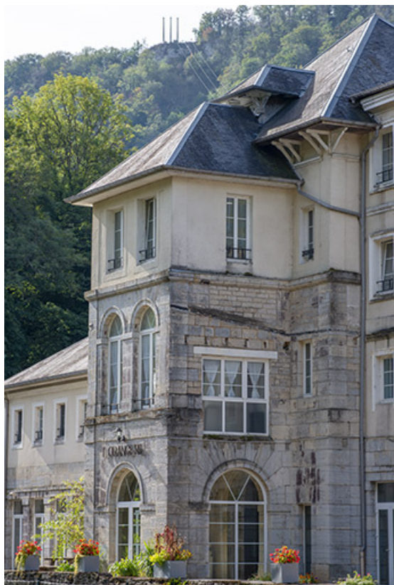
Façade principale, vue de trois quarts, détail : avant-corps central. 25, Guillon-les-Bains route départementale 21, lieudit : les Bains
