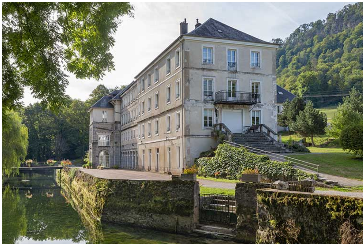
Extension ouest construite vers 1900-1910, vue de trois quarts.
